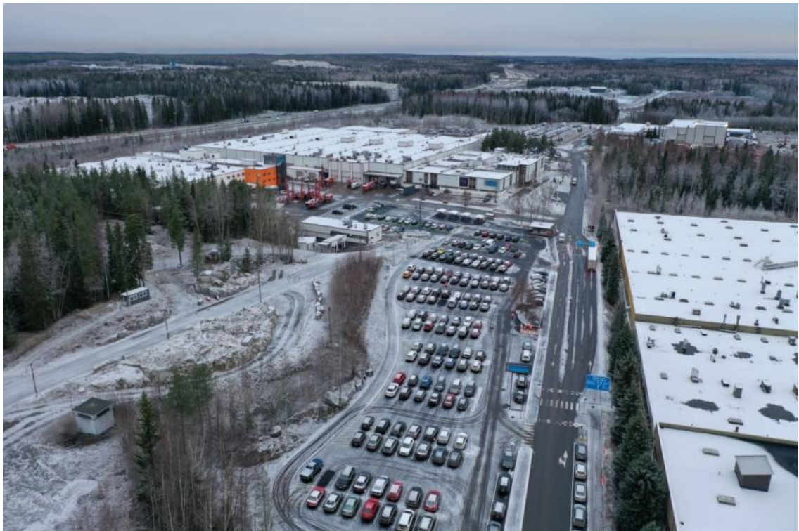
KUVA 2. Tampereen tehdas (Sandvik 2023)
