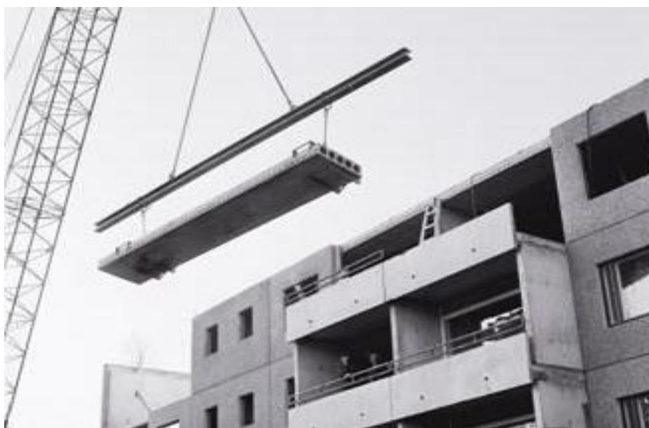
KUVA 2. Elementtien asennusta. (Elementtisuunnittelu.fi)
