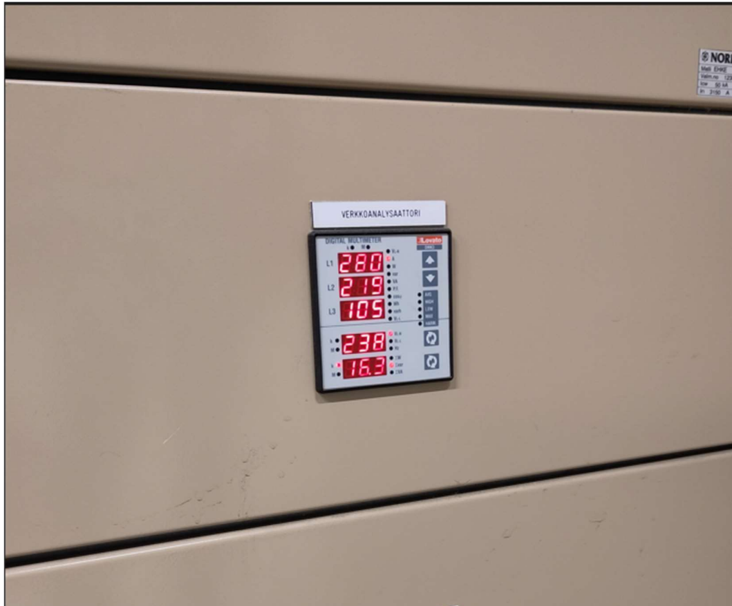
Kuva 17 PKA1-virtamittarit.
