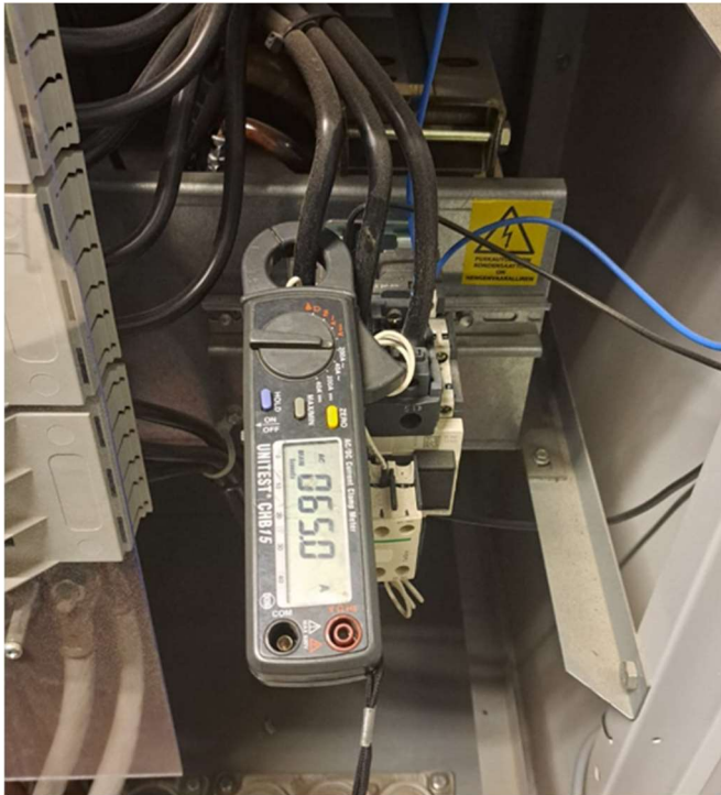
Kuva 41 Viallinen PKB3-kontaktori
