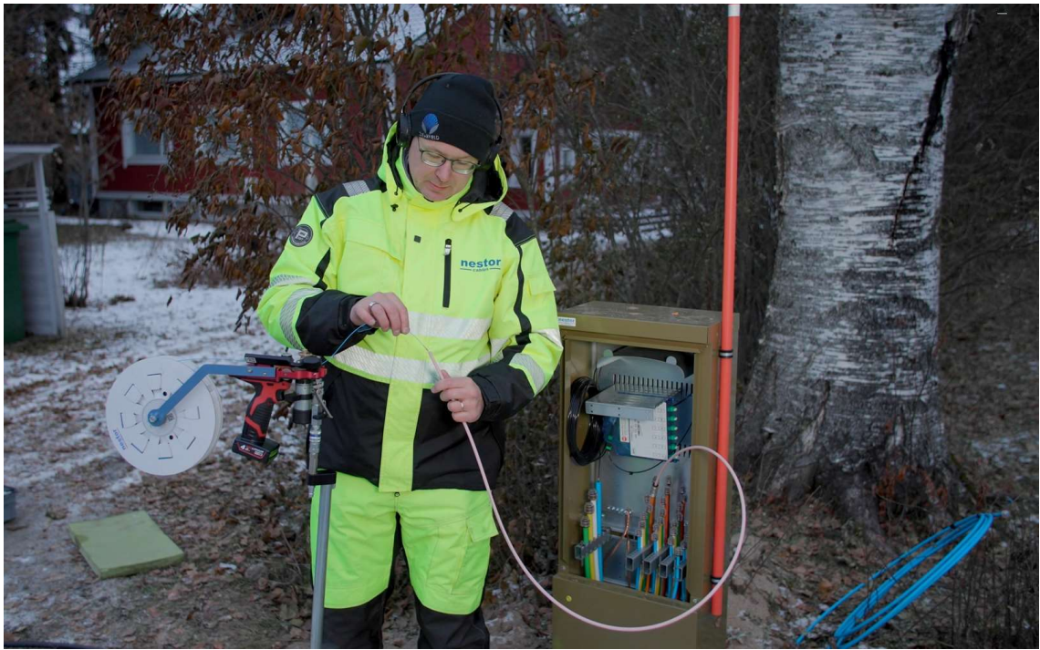
KUVA 13. NBFU-kaapelin puhaltaminen mikrokanavaan (Juliander 2024).
