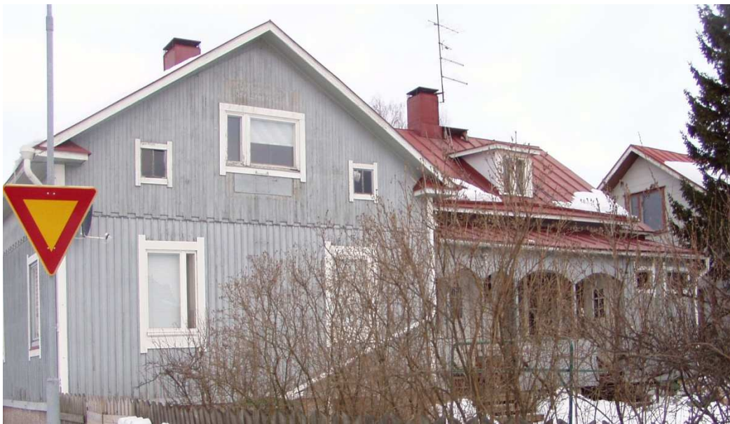
Kuva 2. Rakennus sisäpihalta päin. (Kuvassa vasemmalla ylhäällä varastotilana toimivan huoneen iso ikkuna.)
