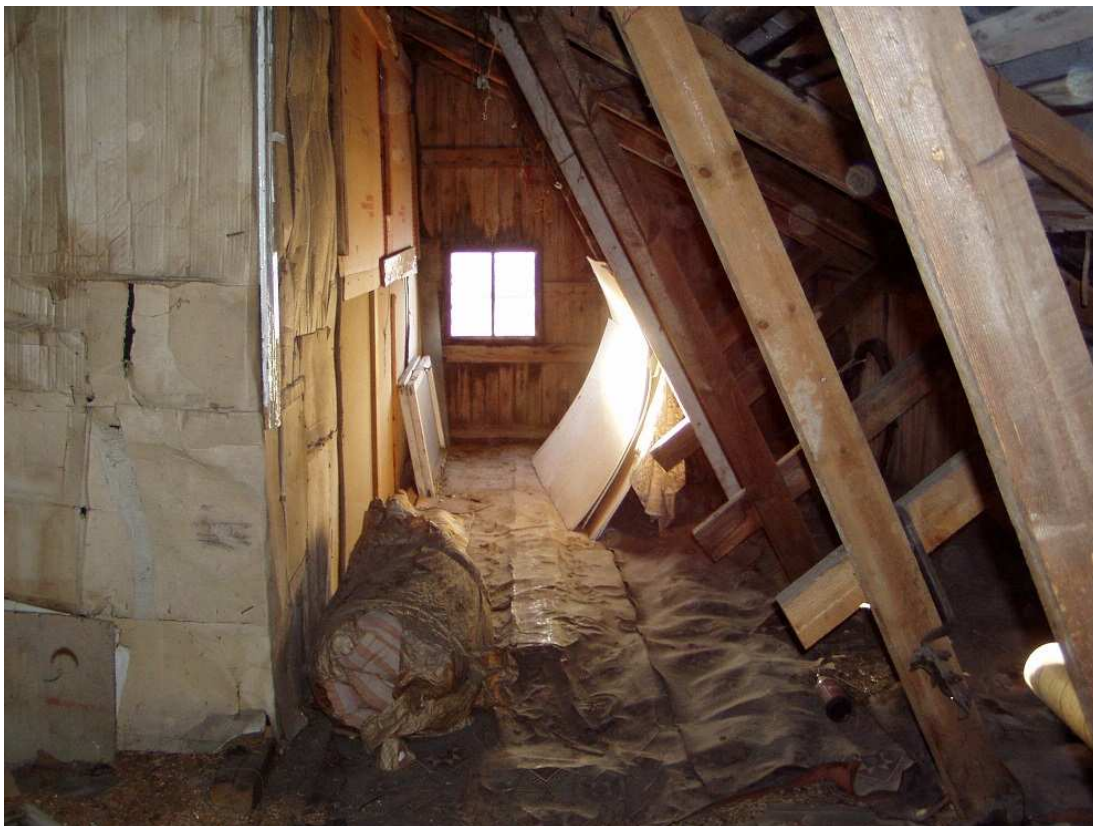
KUVA 3. Ullakon ainoa ikkuna
