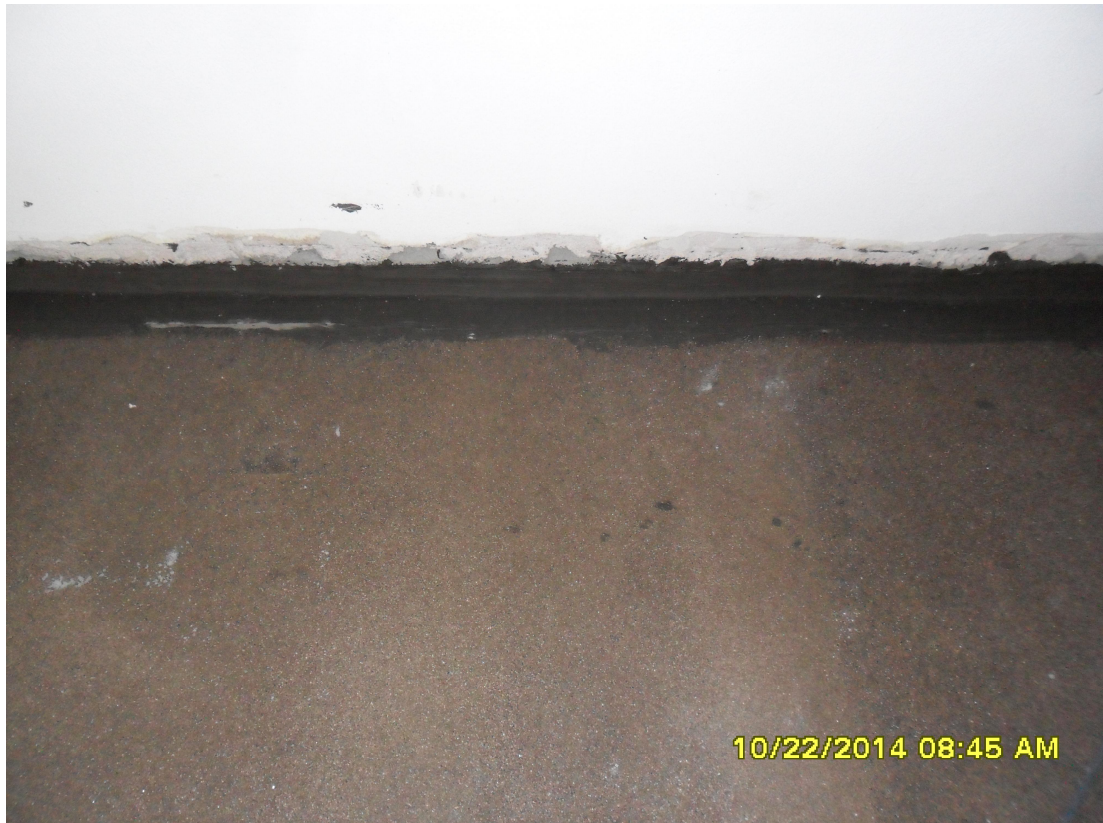
Kuva 6. Lattia valmiina tasoitettavaksi. Rajapinta valmiina kitattavaksi.
