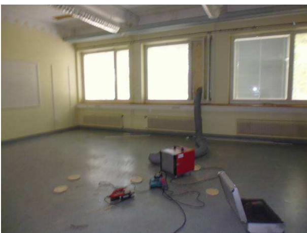
Tiloissa oli käytössä alipaineistus purkutöiden aikana.
