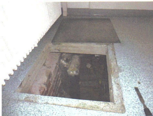
Putkikanaalin tarkastusluukku lattiassa ja seinässä.
