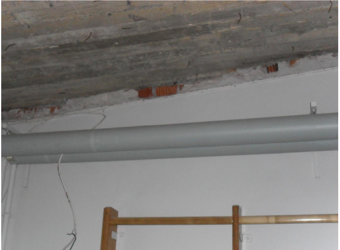
Kuva 4. Seinän ja katon rajapinta, purkamisen jälkeen. Kolot näkyvissä.
