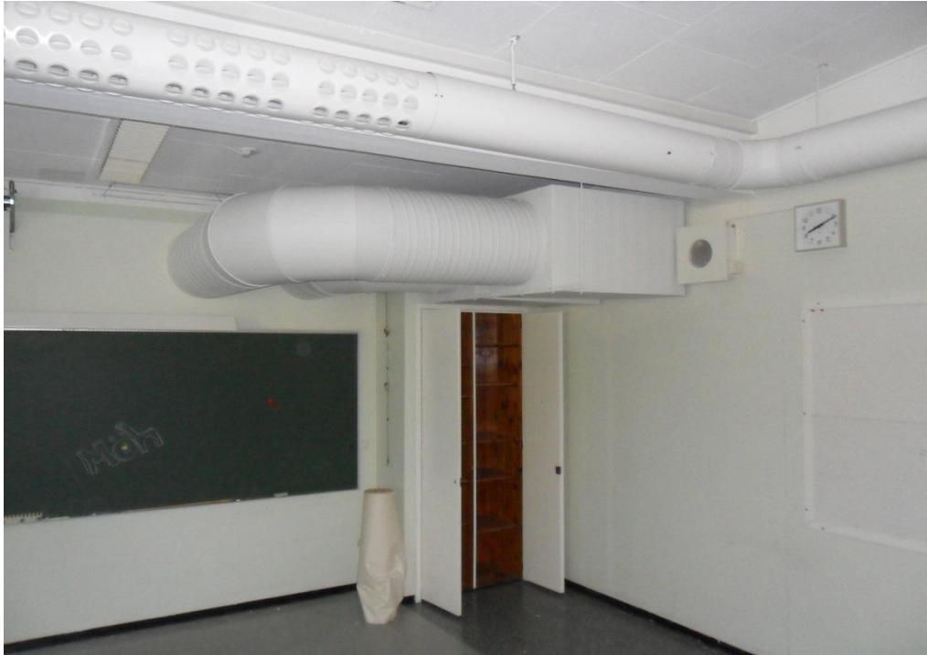
Kuva 2 Ilmanvaihtokanavat purkamisen tiellä.
