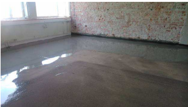
Uuden tasoitteen asentamista valmistajan ohjeiden mukaisella vesiseossuhteella.
