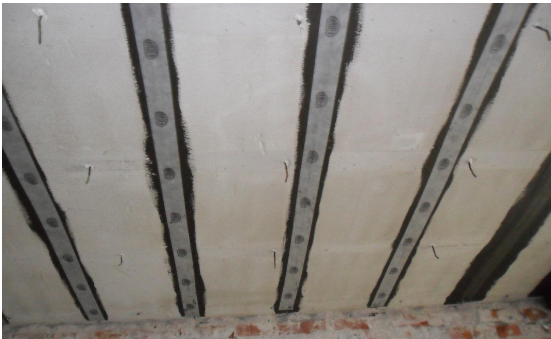
Kuva 5. 2. kerroksen kevytbetoni-lankkujen tiivistys STB-nauhalla sekä 8+9 vedeneristeellä.
