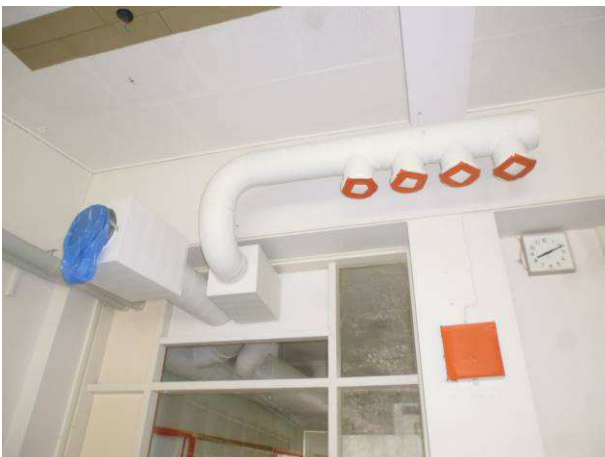
Iv-kanavat suljettu ilmatiiviisti.
