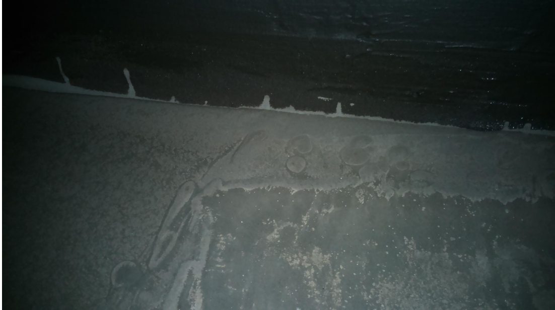
Kuva 8. Eroittunutta tasoitetta.
