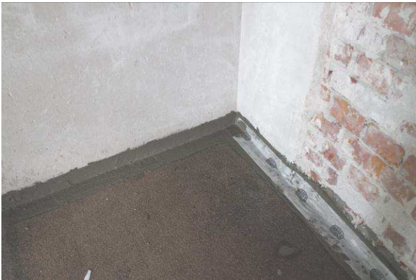
Rakenteiden liittymien tiivistystä kosteus- ja haitta-ainekäsittelyn jälkeen.
