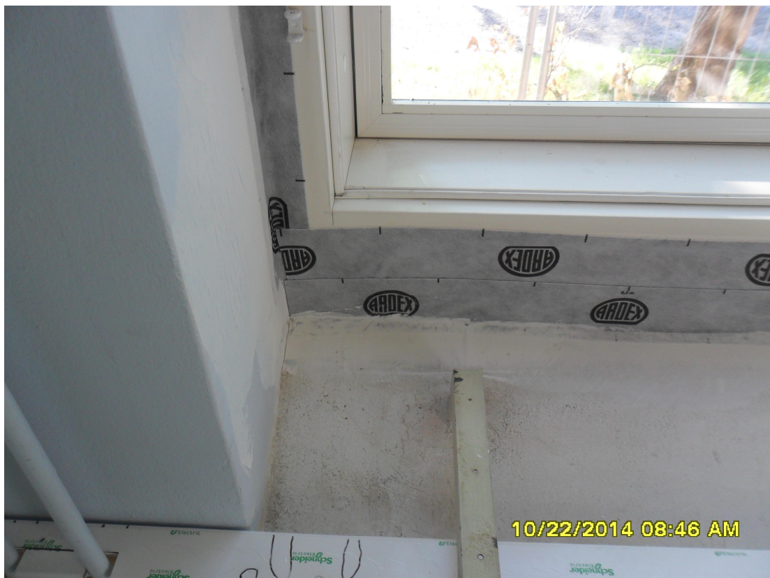
Kuva 7. Ikkunan ja seinän rajapinnan tiivistys STB-nauhalla. Limitys alaohjauspuun kohdalla.
