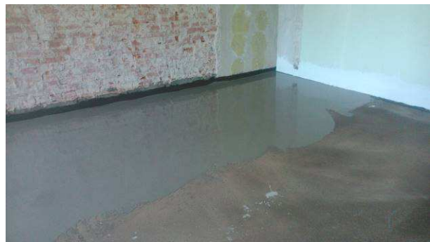
Uuden tasoitteen asentamista valmistajan ohjeiden mukaisella vesiseossuhteella.
