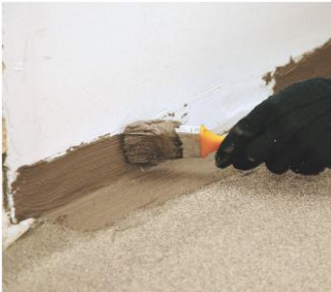
Lattian ja seinän rajakohdat tiivistetään ARDEX EP 2000 -höyrinsulun päälle ARDEX 8+9 -vedeneristeellä ja ARDEX SK 12 -vahvistusnauhalla.
