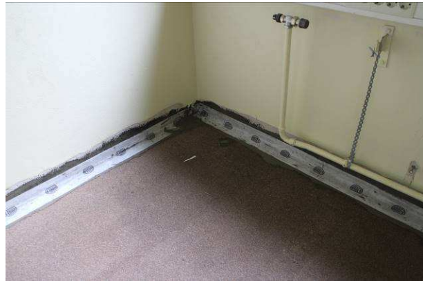
Rakenteiden liittymien tiivistystä kosteus- ja haitta-ainekäsittelyn jälkeen.
