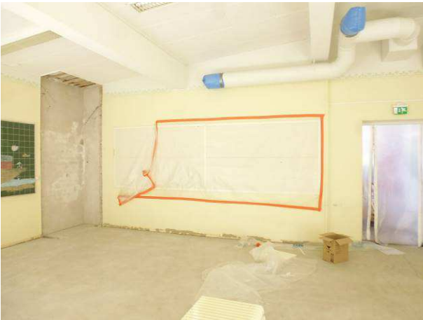
Yleiskuvia purkutöiden ja asbestisiivouksen jälkeen.
