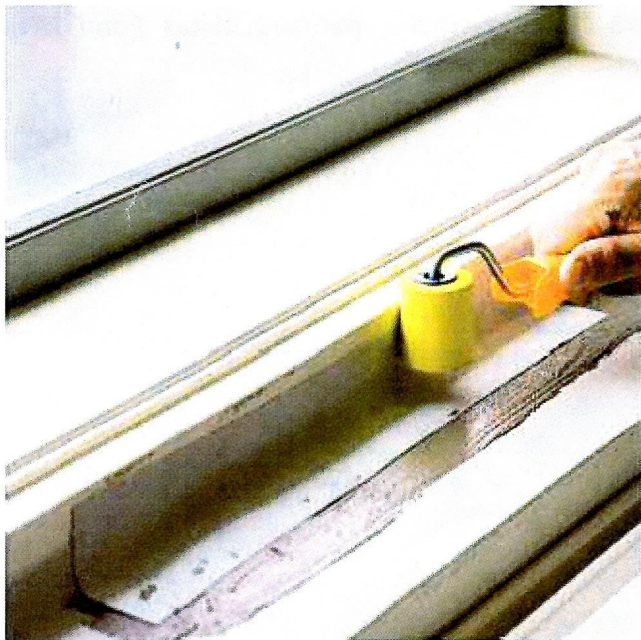
Karmitiivistys tehdään sementtipohjaisella ja kutistumattomalla ARDEX 8+9 -vedeneristeellä ja ARDEX STB -vahvistusnauhalla.
