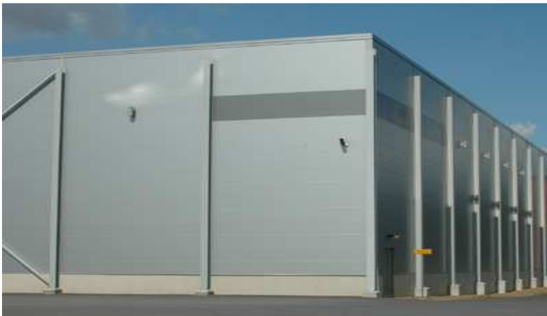
Kuva 2. Saarioisten logistiikkakeskus, Valkeakoski [2].
