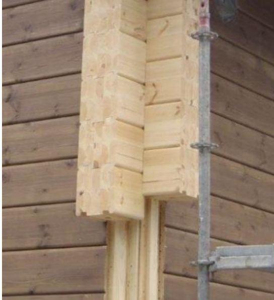
Kuva 4. Valenurkan kasaus FinnCopan rakenteessa (Visillan työmaa 2012)
