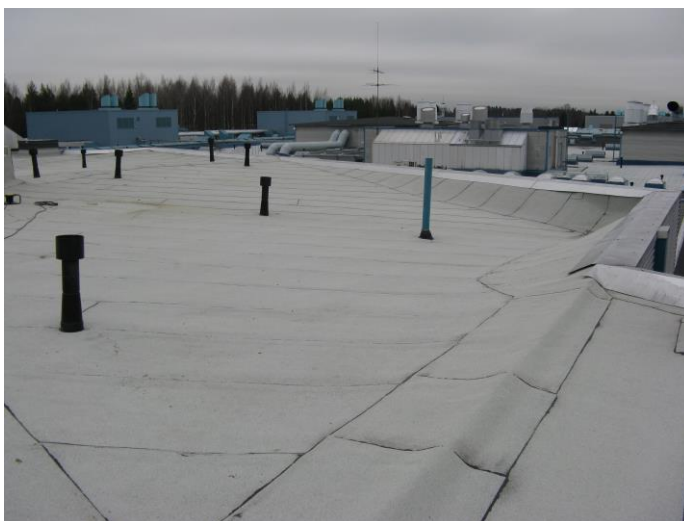
Kuva 52: Huutokauppasalin valmis katto. Kuva otettu 14.11.2014.
