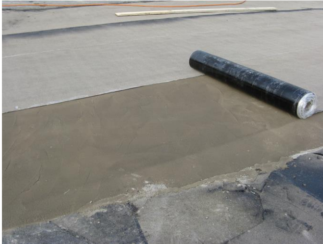
Kuva 51: Valettu alue päällystettiin kermillä jo samana päivänä. Kuva otettu 3.10.2014.
