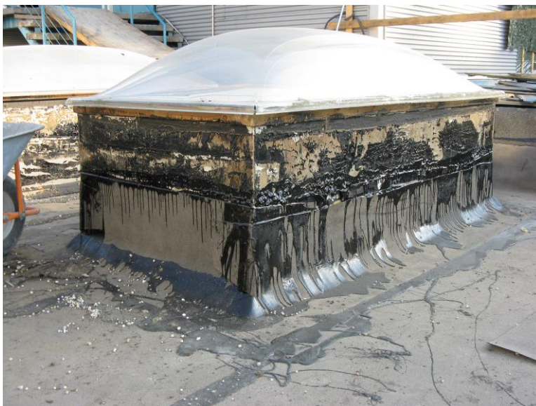
Kuva 37: Kattoikkunan sokkeliin tehty ylösnosto veden torjumiseksi. Kuva otettu 23.7.2014.
