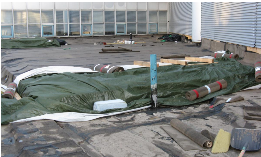
Kuva 48: Kesken jääneen katon suojaus pressulla. Kuva otettu 22.8.2014.
