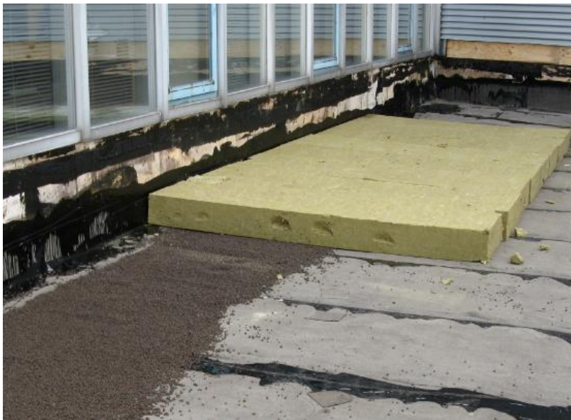
Kuva 46: Lämmöneristeiden ensimmäinen kerros. Kuva otettu 15.8.2014.
