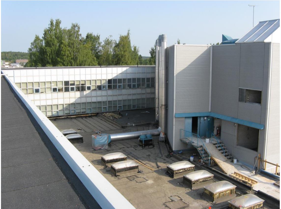
Kuva 28: Korjattava vesikatto laajemmasta näkökulmasta. Kuva otettu 29.7.2014.
