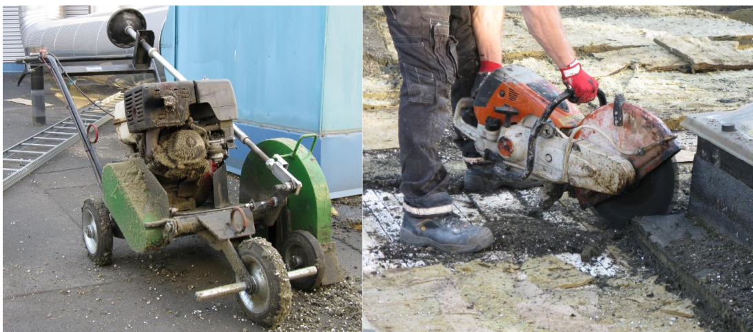
Kuva 34: Vesikaton avaamisessa käytettyjä työkaluja. Kuvat otettu 23.7.2014.
