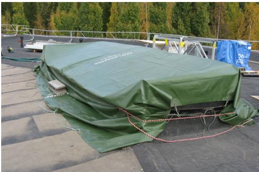
Kuva 43: Puretun savunpoistoluukun sääsuojaus. Kuva otettu 3.10.2014.
