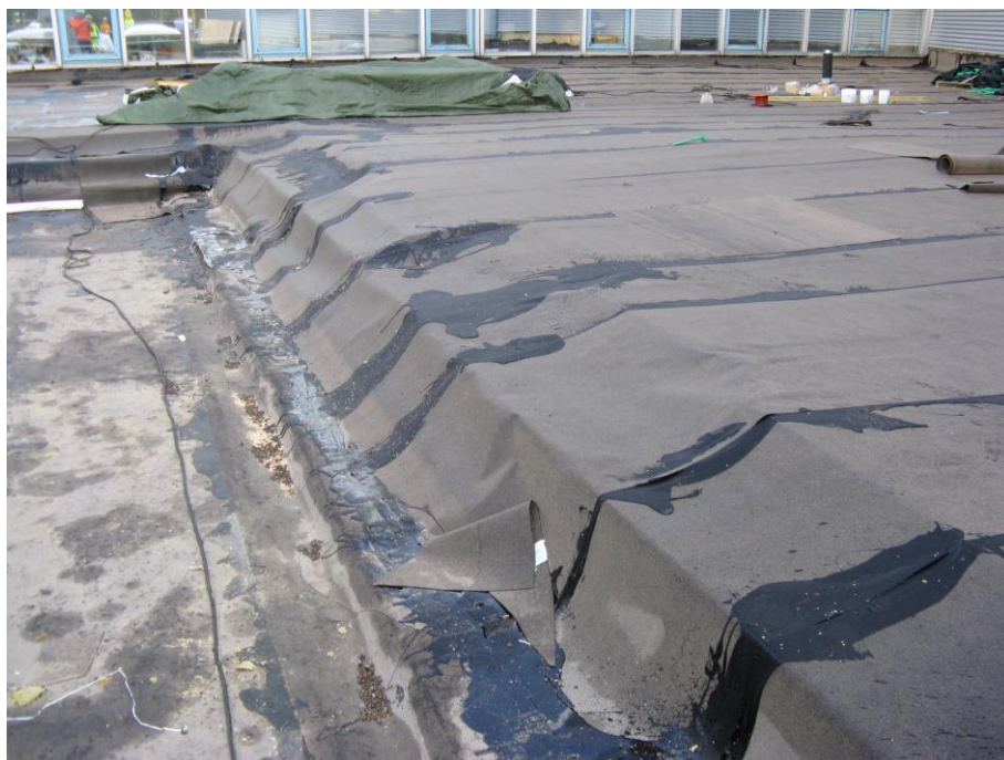
Kuva 49: Kesken jääneen katon suojaus bitumikermeillä. Kuva otettu 22.8.2014.
