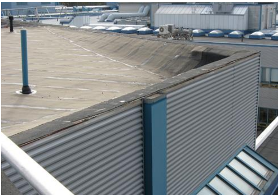
Kuva 44: Rästäs rakenne, josta on purettu pellit pois. Kuva otettu 3.10.2014.
