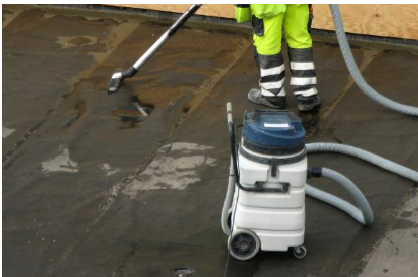
Kuva 40: Veden imurointia katolta. Kuva otettu 15.8.2014.
