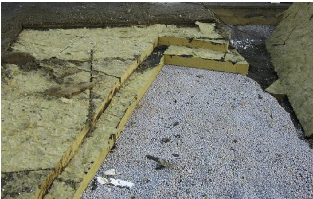
Kuva 36: Henkilöstöravintolan ja valmistuskeittiön vesikaton rakenne. Kuva otettu 23.7.2014.
