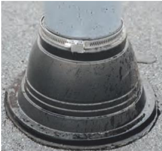
Kuva 13: Läpivientilaippa bitumikermikatolla [3, s. 35].
