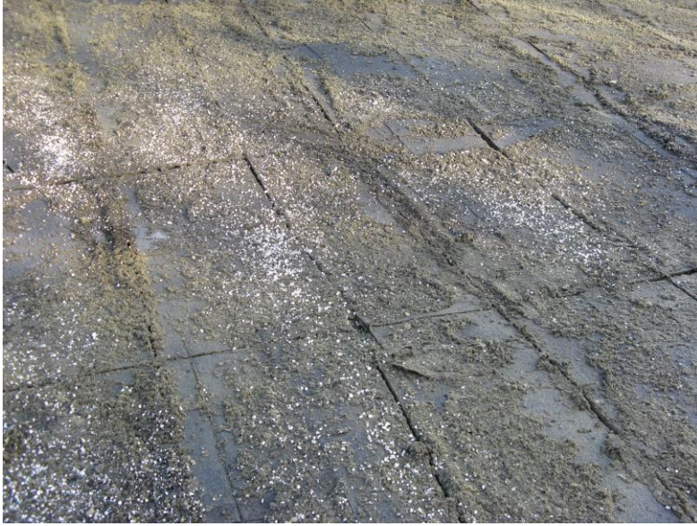
Kuva 35: Timanttisahalla tehdyt aukaisuviillot katemateriaaliin. Kuva otettu 23.7.2014.
