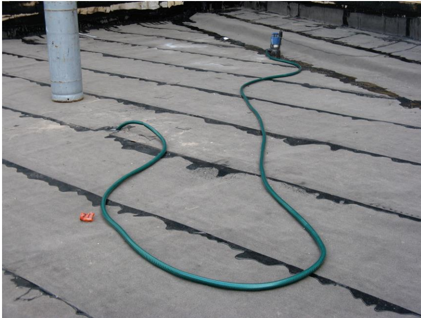
Kuva 39: Uppopumppu höyrynsulun päällä. Kuva otettu 15.8.2014.
