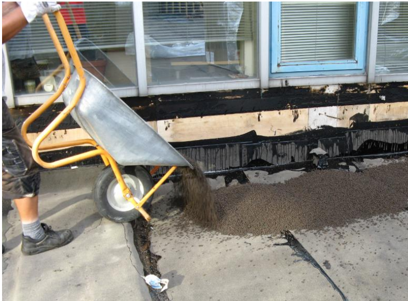
Kuva 45: Kevytsoran levitys höyrynsulun päälle. Kuva otettu 15.8.2014.
