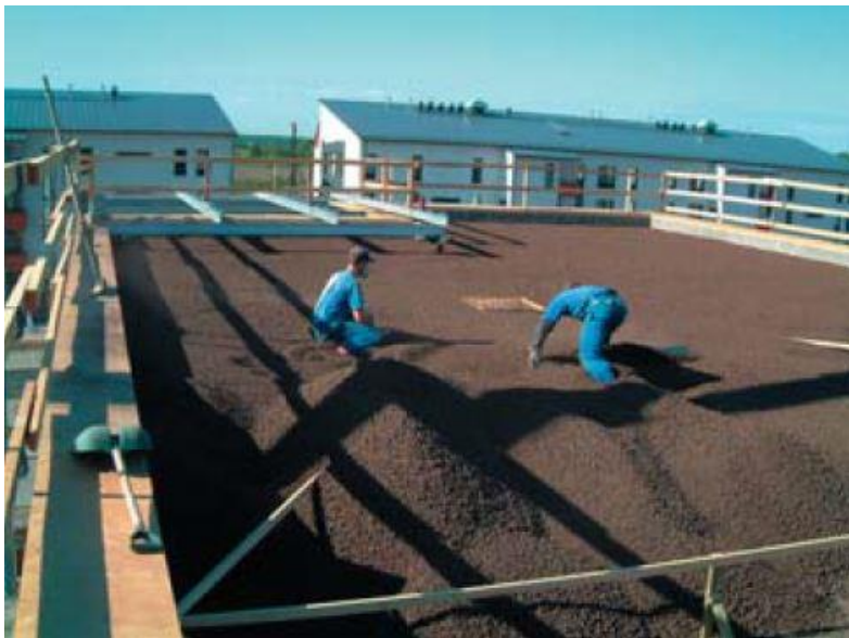
Kuva 8: Kevytsoran levitys katolla [12, s. 22].
