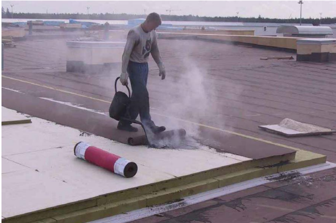
Kuva 4: Liimausbitumin kaataminen kannusta [9, s. 6].
