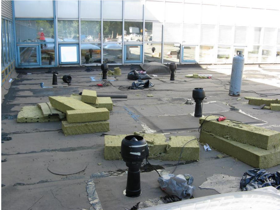
Kuva 56: Alipainetuulettimia asennettuina katon kuivatusta varten. Kuva otettu 5.9.2014.
