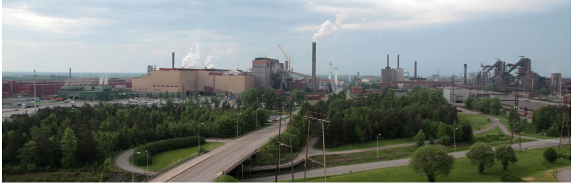
Kuva 3. Raahen tehdasalue. (Raahen terästehtas opas 2014)
