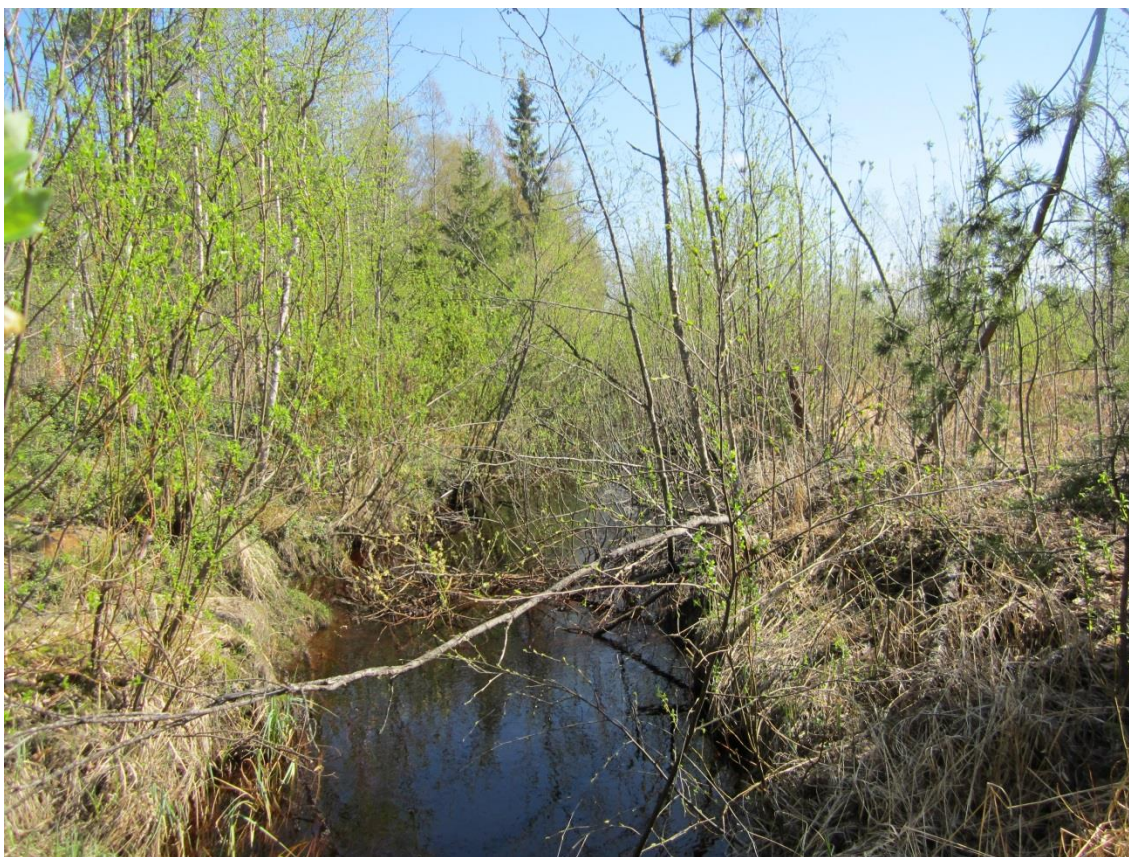
KUVA 14. Korteojan uoma alavirrasta päin kuvattuna
