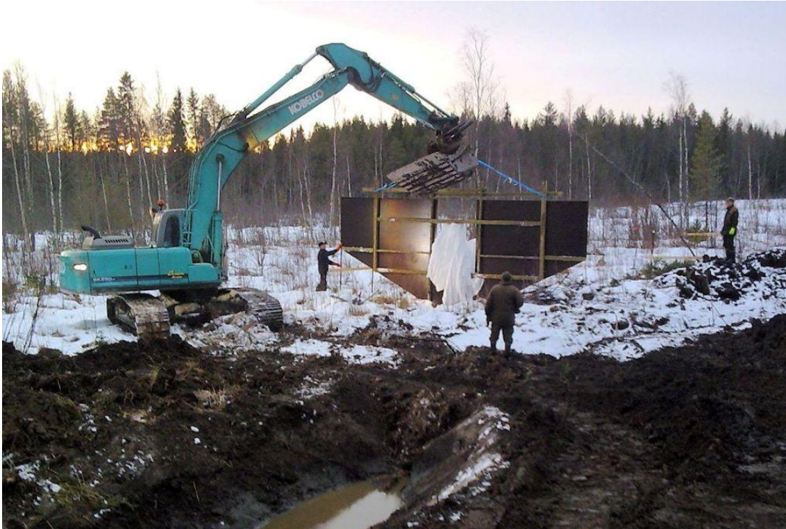
KUVA 16. Kaivinkone nostamassa valmiiksi koottua neulapadon runkoa paikalleen (Kiimingin-Jäälän vesienhoitoyhdistys)
