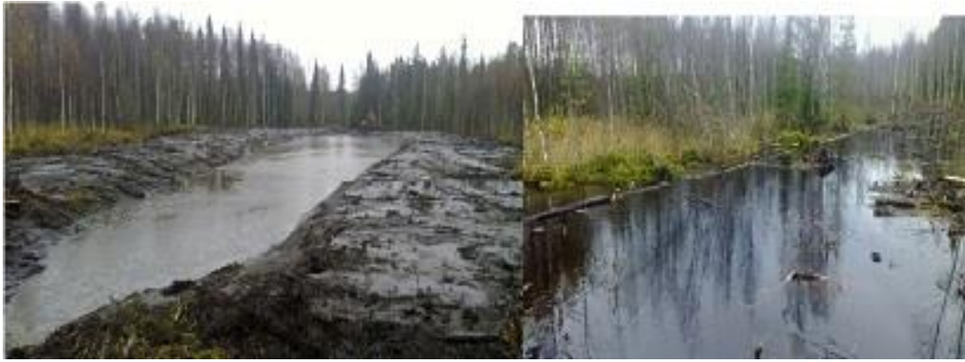
KUVA 6. Syksyllä 2012 Saarisenojan valuma-alueelle tehtyjä vesienhoitorakenteita (Savolainen, 2012).
