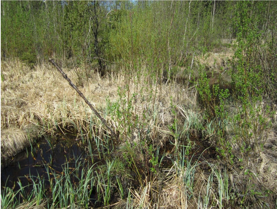
KUVA 22. Pintavalutuskentältä tuleva vesi on syövyttänyt aukon ojanpenkereeseen
