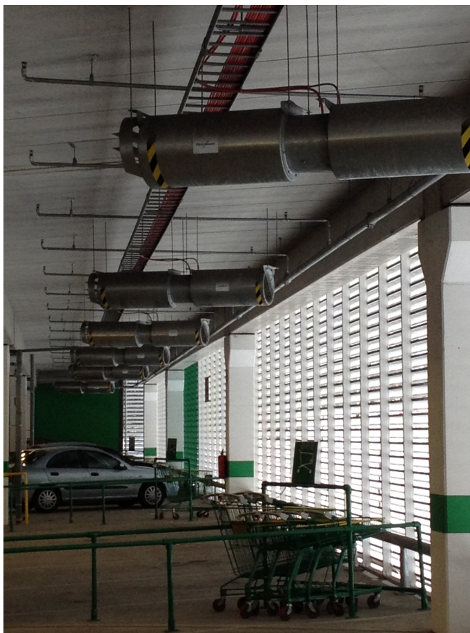
KUVA 16. Esimerkkitapaus tulo-/korvausilman johtamisesta pysäköintitilaan
