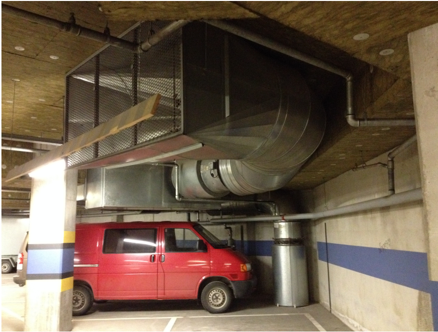
KUVA 2. Esimerkki suurten kanavakokojen tilavaatimuksista pysäköintitiloissa
