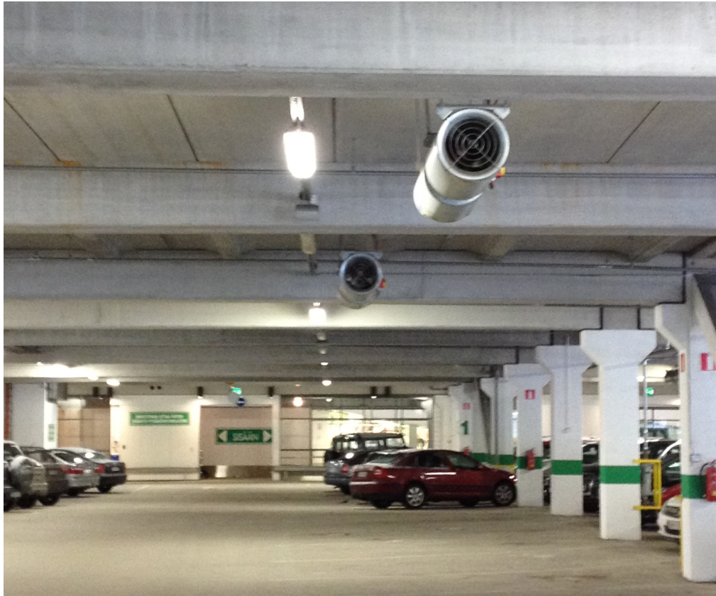
KUVA 5. Pysäköintitilan kattoon asennettuja suuntapainepuhaltimia
