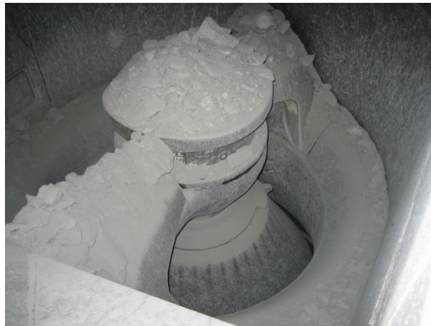
Kuva 7. Ylärungonsuojauksen päälle kertynyt suojakerros /3/
