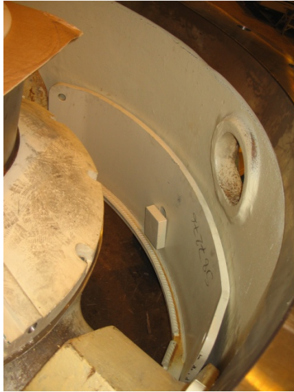
Kuva 13. Alahelmansuojat murskaimen alarungossa /3/
