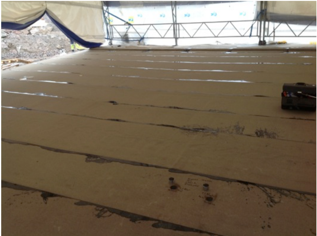
Kuva 5. Sillan kannen ensimmäinen kermieristekerros, josta on otettu tartuntavetolujuuskokeet seuraavaa kermikerrosta varten.
