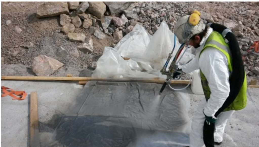
Kuva 18. Elastomeerin koeruiskutus muovin päälle ennen varsinaisen vedeneristystyön aloittamista.
