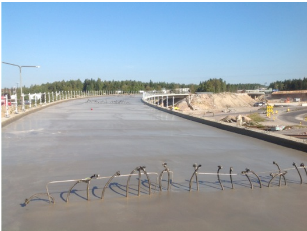
Kuva 19. Valmis ja tasalaatuinen elastomeeripinnoite.
