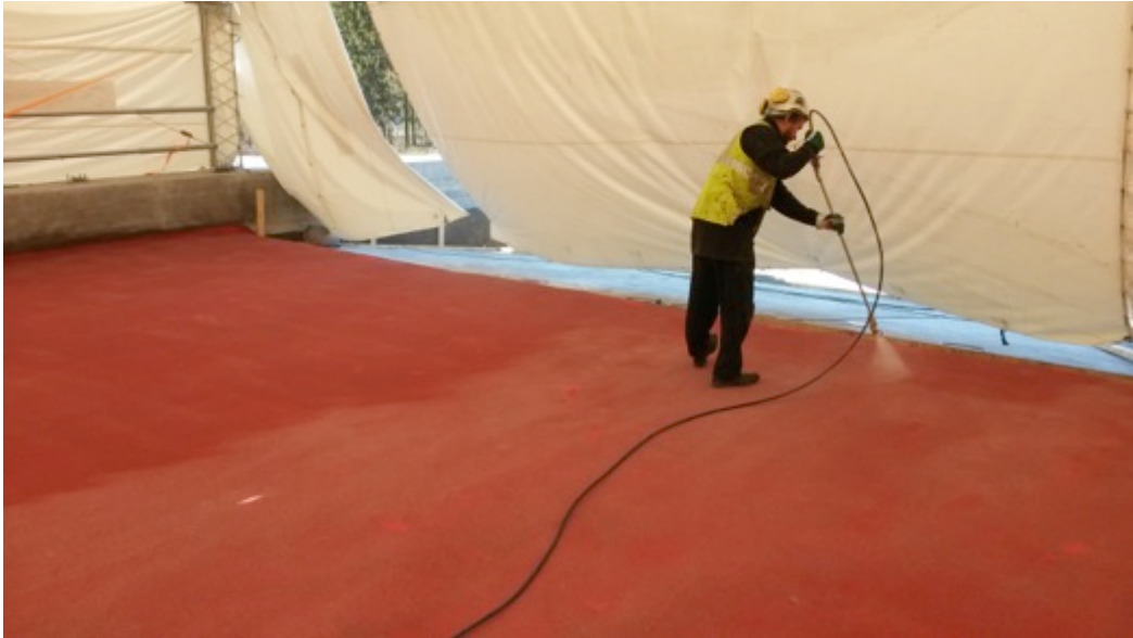
Kuva 14. StoPur VS 70 tartuntaprimerin levitys.
