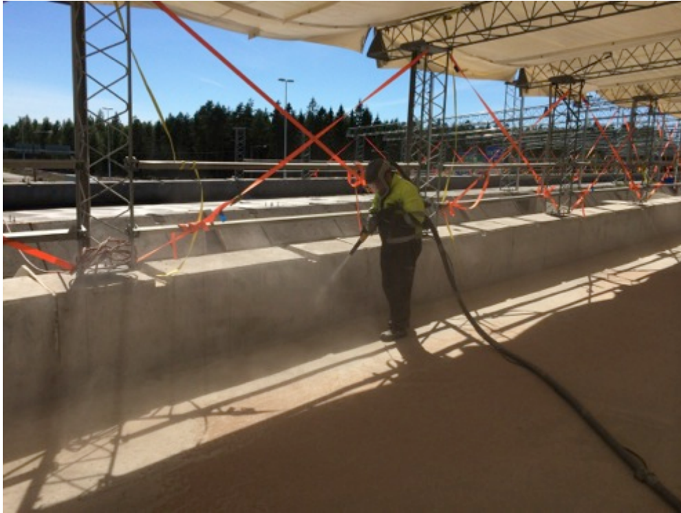
Kuva 3. Hiekkapuhallusta käytetään reunapalkkeihin ja sillankannen niihin osiin, joita ei pystytä sinkopuhaltamaan.
