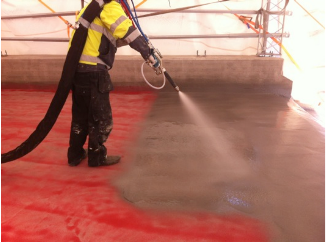
Kuva 15. Elastomeeripinnoitteen ruiskutus tartuntaprimerin päälle riittävän haihtumisajan jälkeen.
