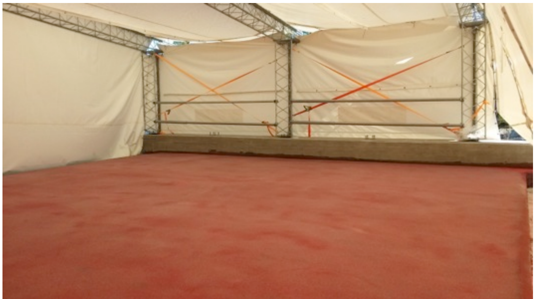
Kuva 4. Sillan kannen valmis epoksitiivistys.
