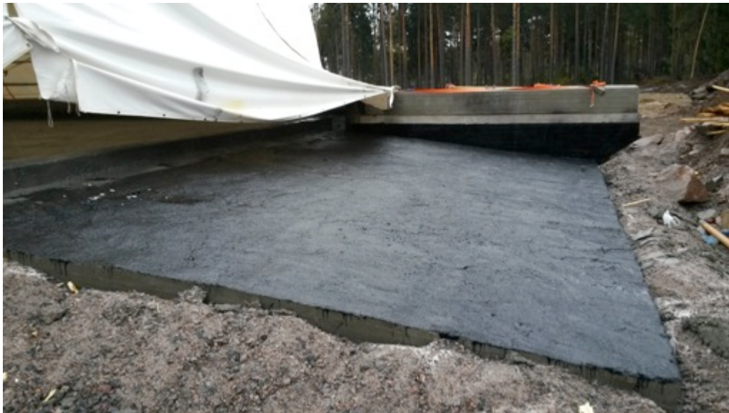
Kuva 6. Pikityö on suoritettu siipimuurien, siirtymäläattojen, reunapalkkien ja limitysten osalta.
