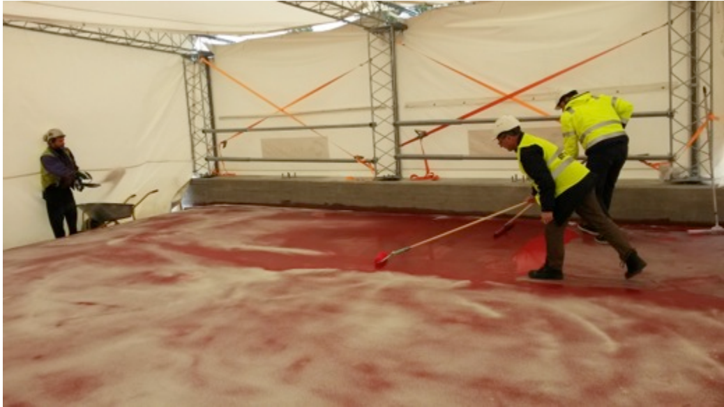
Kuva 13. Epoksointi pienellä sillankannella.
