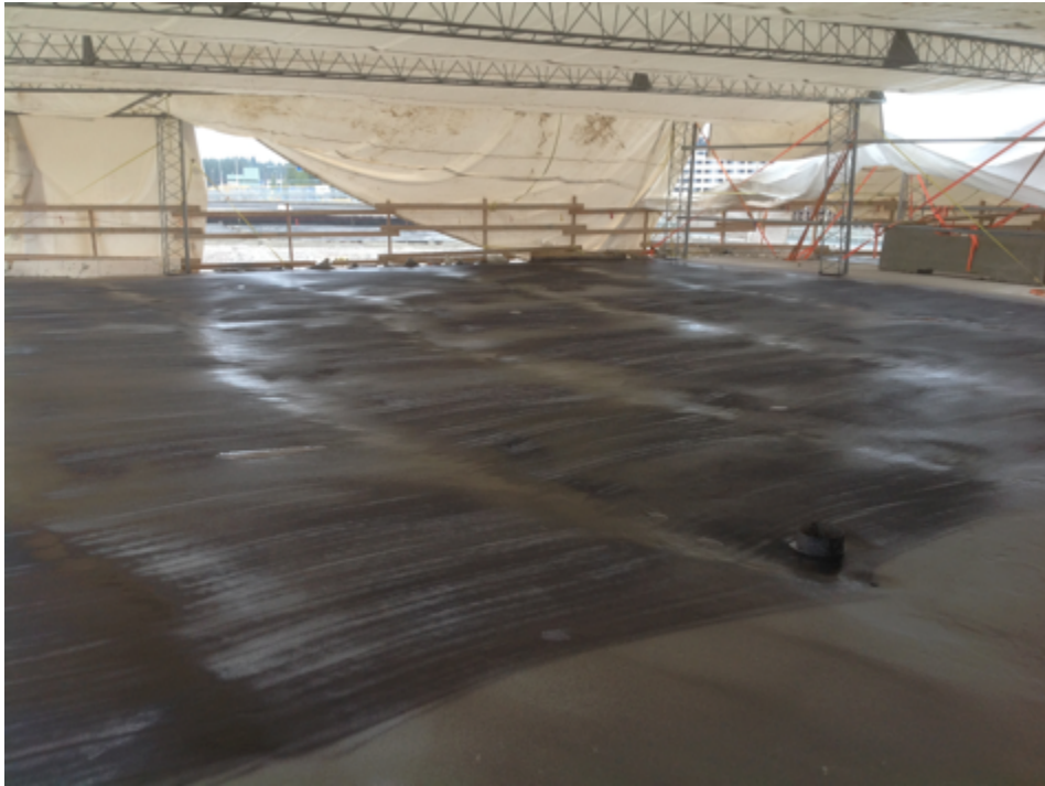
Kuva 17. StoPur VBS 2000:n levitys elastomeeripinnoitteen päälle.
