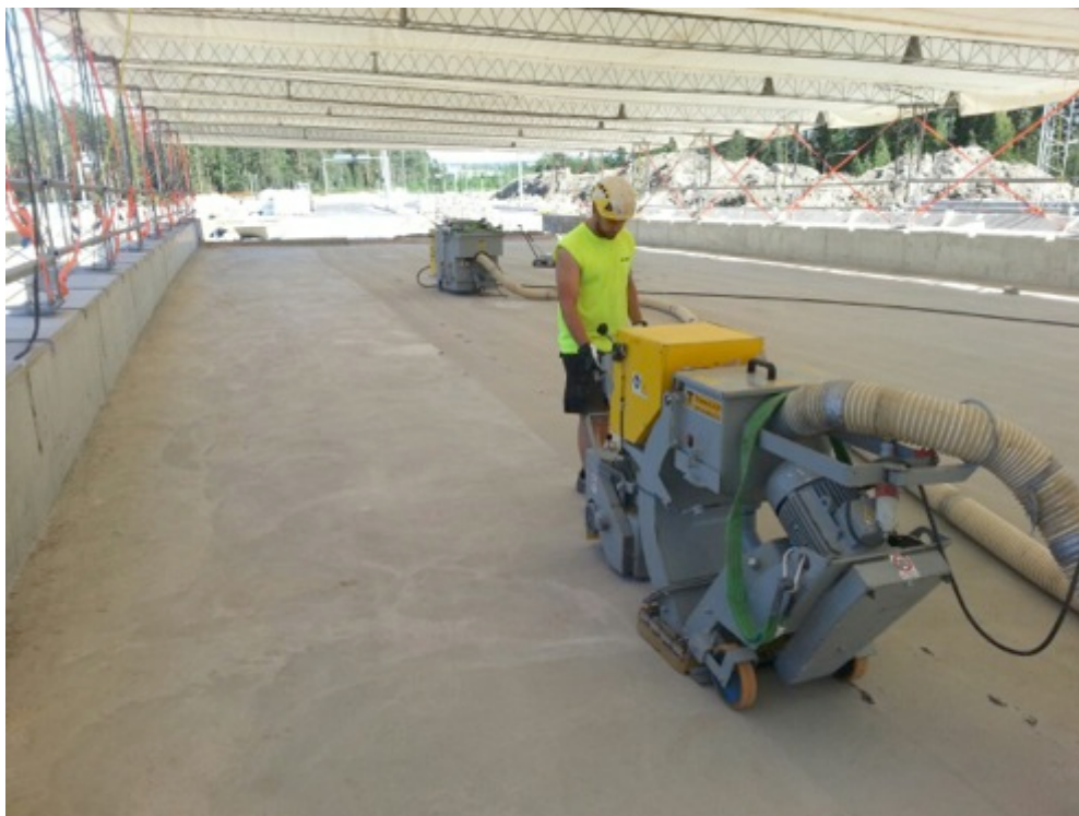
Kuva 2. Sillan kannen esikäsitteily sinkopuhalluksella.
