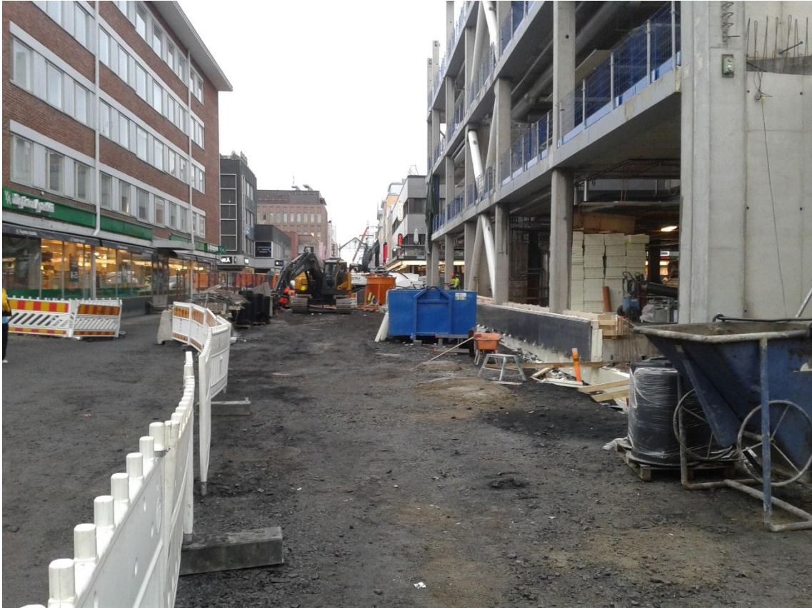
KUVA 7. Kauppurienkadun purkupaikka rakenteilla (purkupaikka 2)
