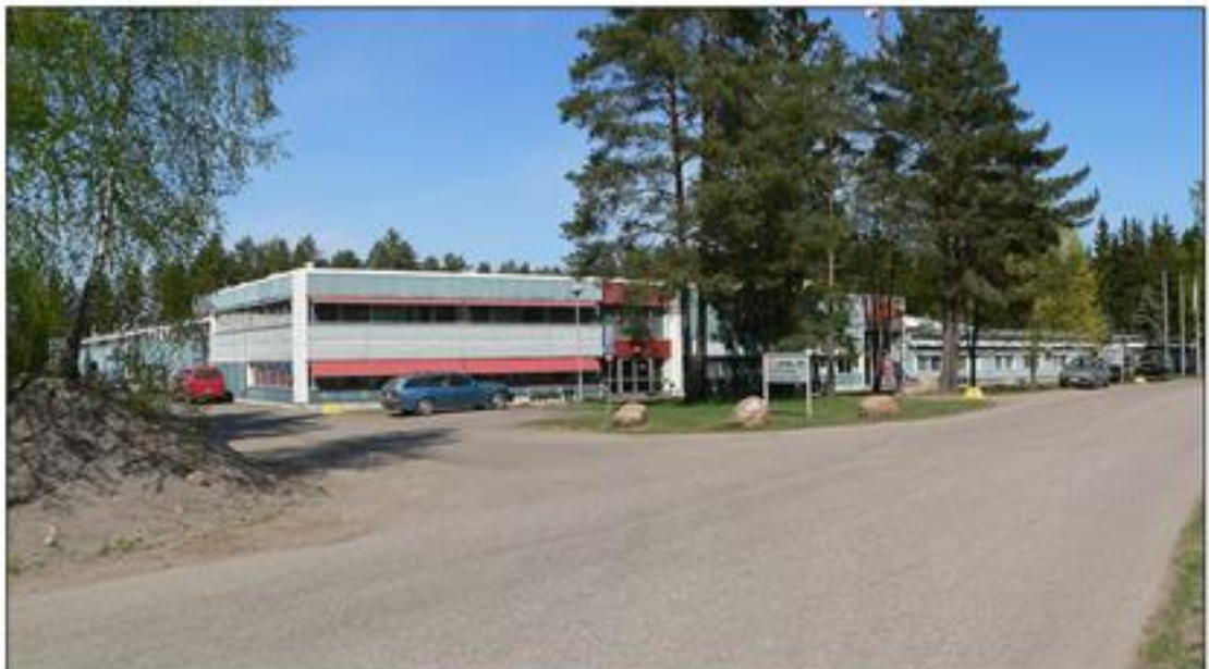
KUVA 1. Loval Oy:n tehdas Loviisassa
