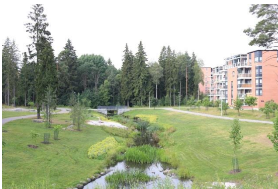
Kuva 190. Esimerkki hulevesikasvillisuudesta avouomassa [5.]
