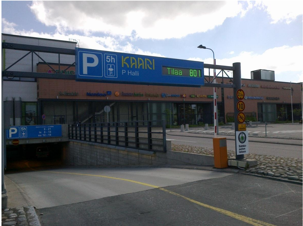
Kuva 16. Kauppakeskus Kaaren pysäköintilaitoksen sisäänajo. Sisäänajon liikenne-merkit ja opasteet ovat muuten asianmukaisesti asennettu, mutta liikenne-merkki (344.), jolla ilmoitetaan ajoneuvon suurin sallittu massa puuttuu.
