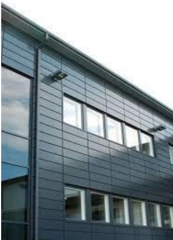
KUVA 6: Valmis kaseteilla päällystetty julkisivu ( www.rttuotetieto.fi )
