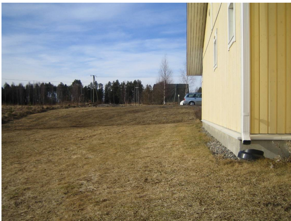
Kuva 3. Pintamaiden kaadot ovat riittävät ja oikean suuntaiset.
