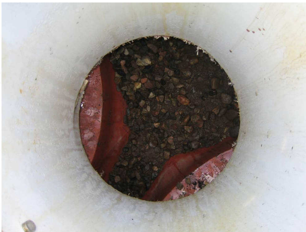
Kuva 1. Soraa ja hiekkaa salaojakaivossa.
