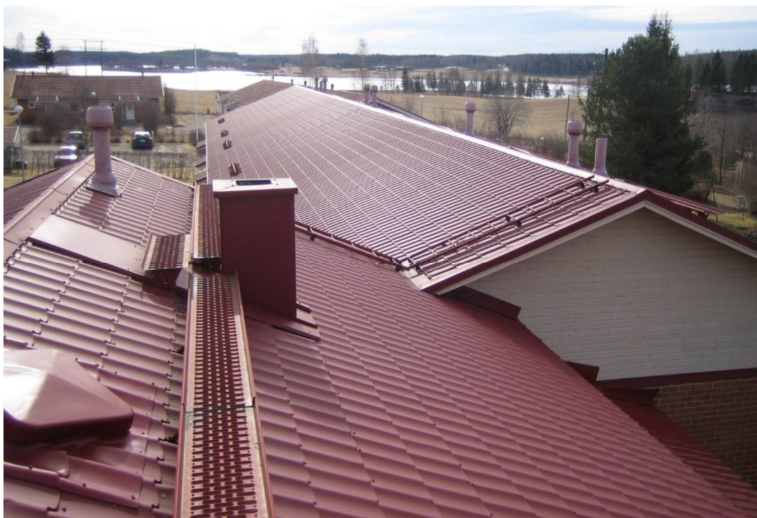
Kuva 16. Vesikattovarusteet ovat hyväkuntoiset.
