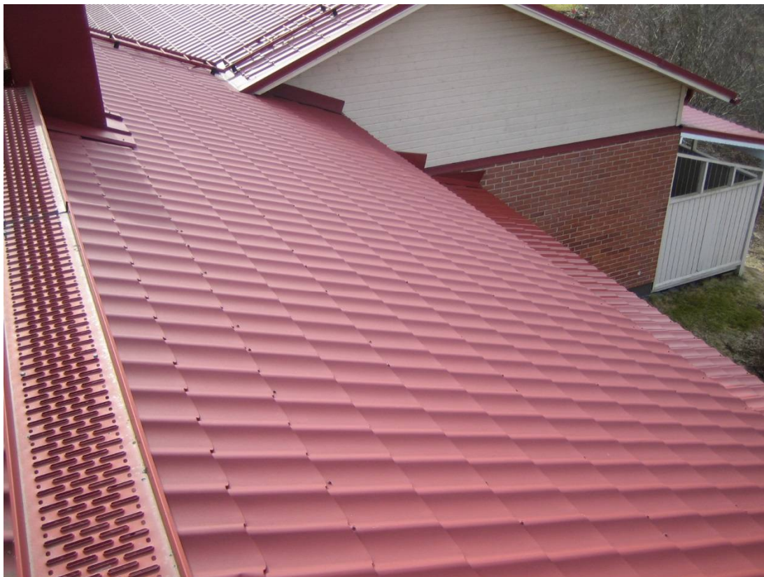
Kuva 15. Vesikate on hyväkuntoinen ja läpiviennit on tehty asianmukaisesti.
