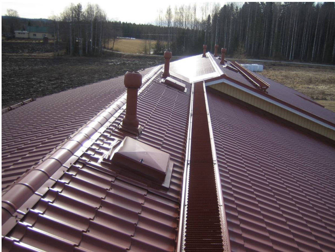
Kuva 19. Vesikate ja kattovarusteet ovat hyväkuntoisia.
