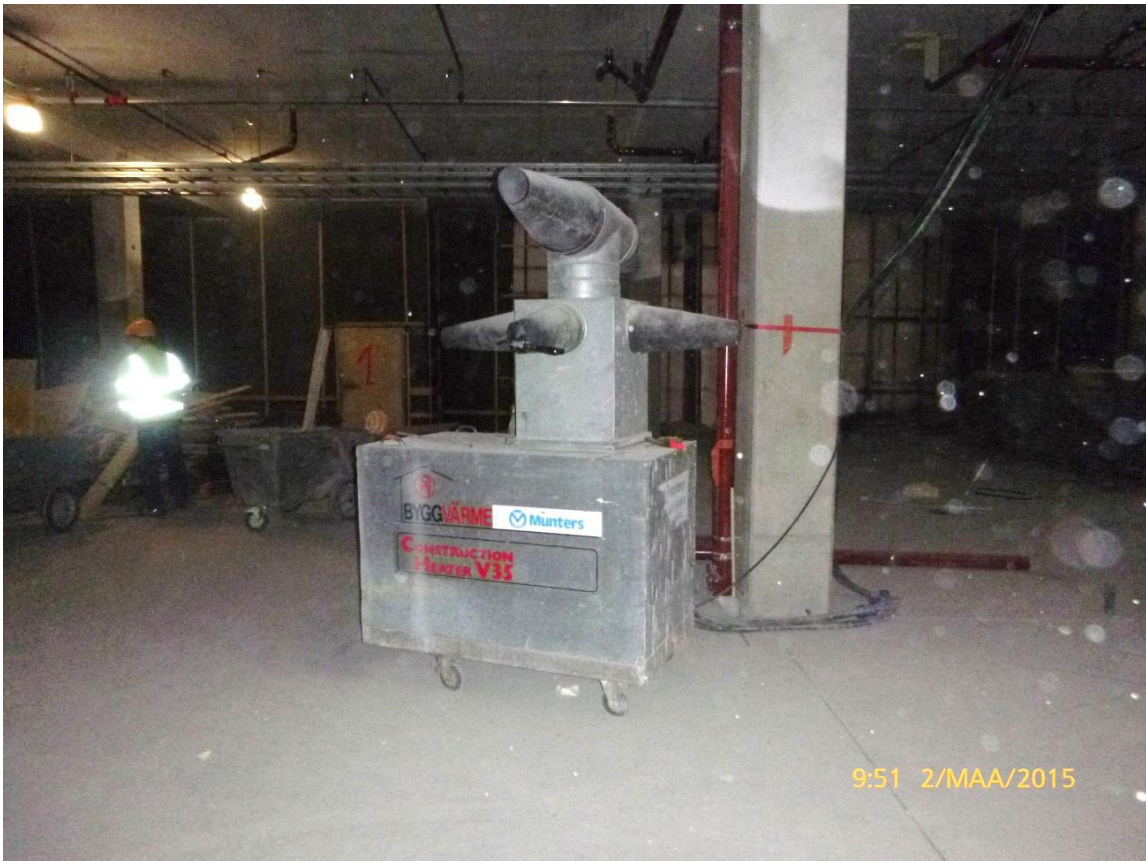
KUVA 7. Talvella sisäilmaa lämmitettiin tehokkailla lämpöpuhaltimilla
