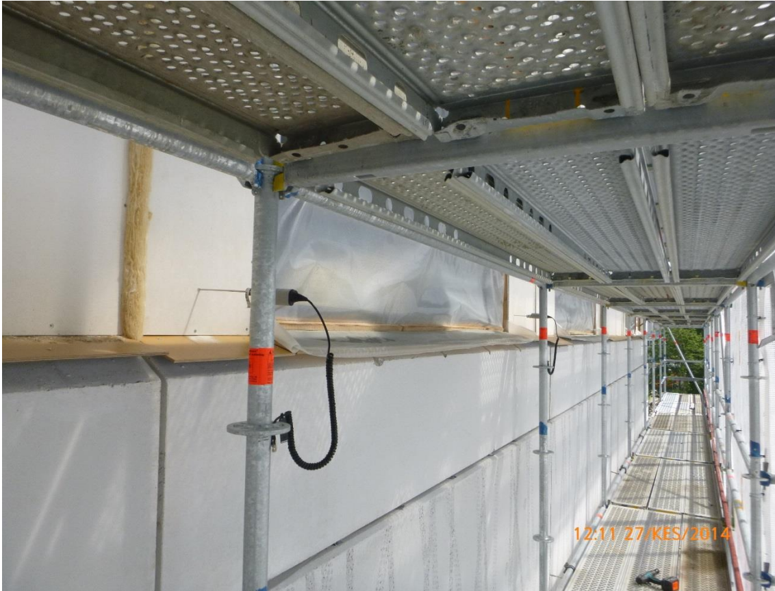
KUVA 17. SW-elementin eristetilan kosteudenmittaus
