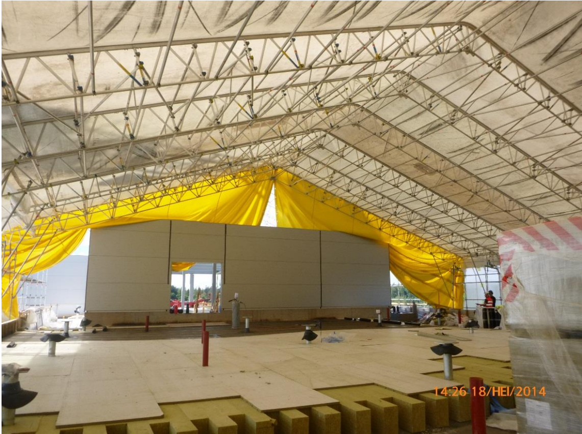
KUVA 5. Yläpohjan eristeet saadaan asennettua sateensuojassa huputuksen alla
