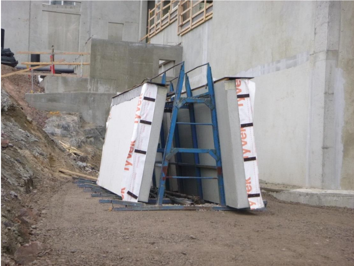
KUVA 11. Elementtien välivarastoidaan työmaalle elementtivakkiin. Tyvec-kangas ja vanerit asennetaan suojaksi
