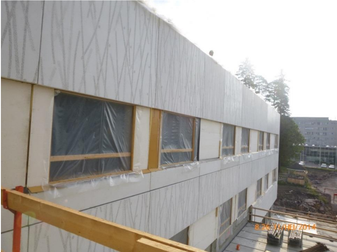
KUVA 10. Ikkunapenkkien suojaksi asennetaan muovikalvot sekä vanerit ohjaamaan veden kulua
