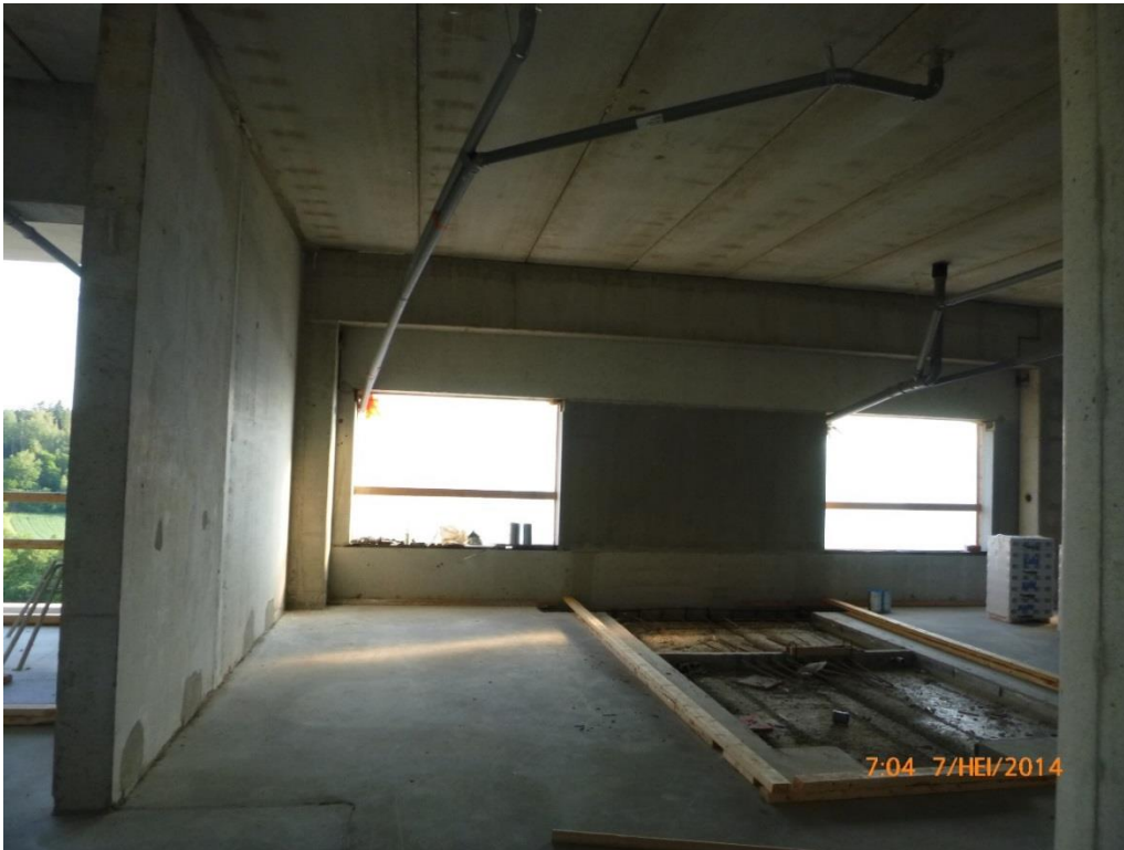
KUVA 14. Vesikaton kaadot johtavat sadevedet kattokaivoille, jotka ovat johdettu väliaikaisesti viemäriputkin elementtien ikkuna-aukkojen läpi rakennuksen ulkopuolelle
