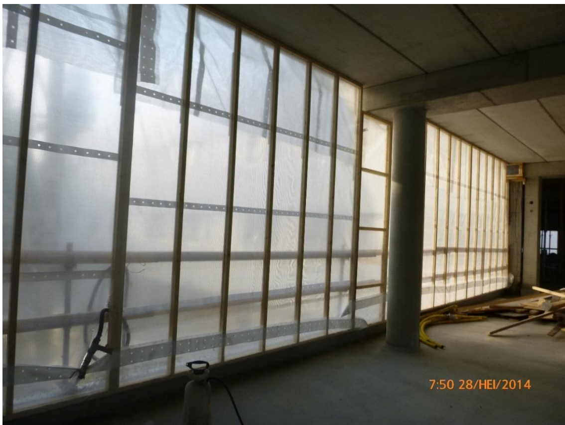
KUVA 15. Avoinna olevan holvin reuna suojattiin sadevesiltä väliaikaisella suojaseinärakenteella
