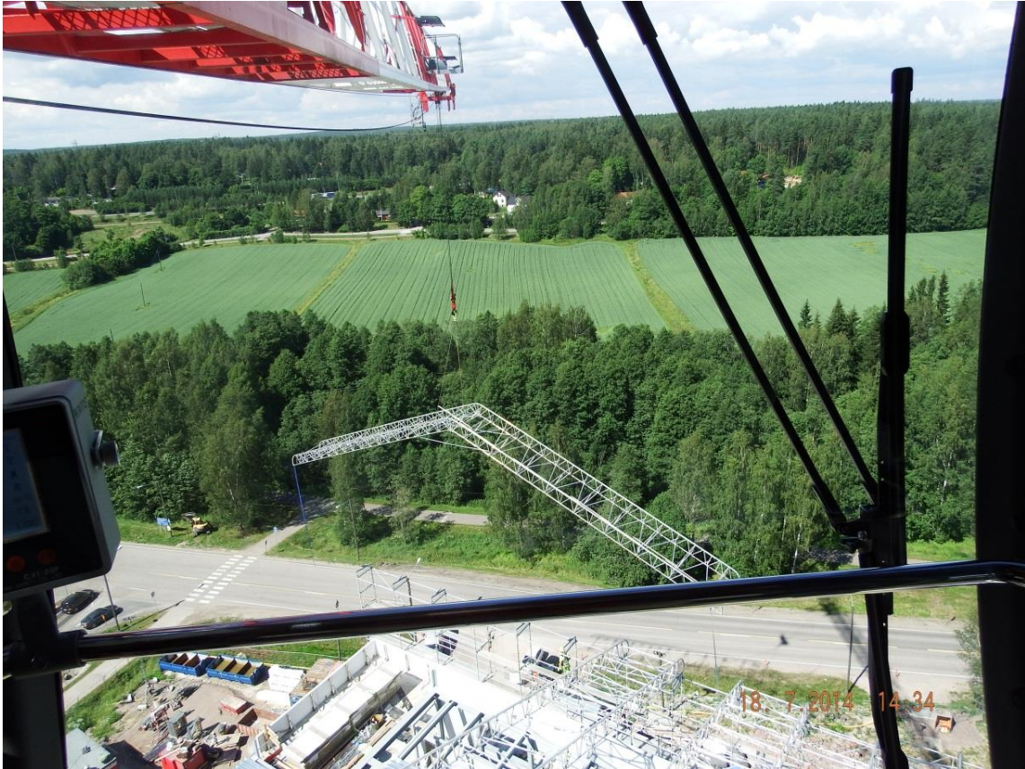
KUVA 4. Valmis rakennuksen päälle tuleva telinerunko nostettiin valmiina palasena paikalleen
