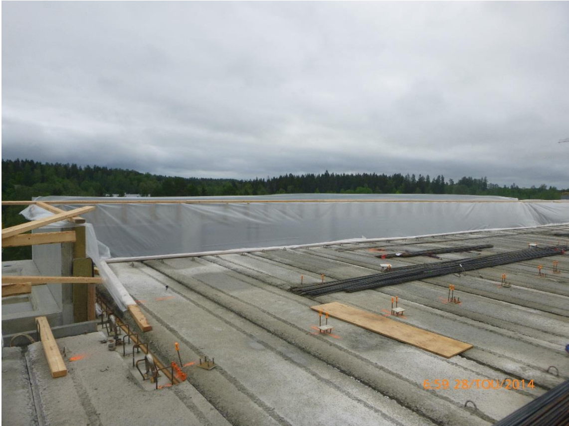
KUVA 13. SW-elementtien eristeet oli suojattava väliaikaisesti muovipeitteellä
