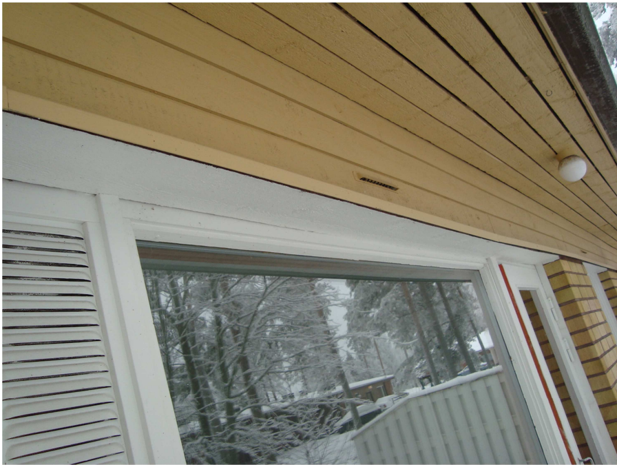
Kuva 4: Ulkoseinän laudoitus ja tuuletusraot
