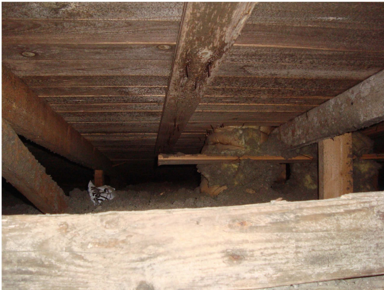
Kuva 11: IV-putken eristys yläpohjassa
