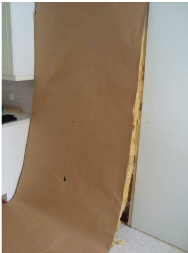
Kuva 5: Keittiön seinää avattu
