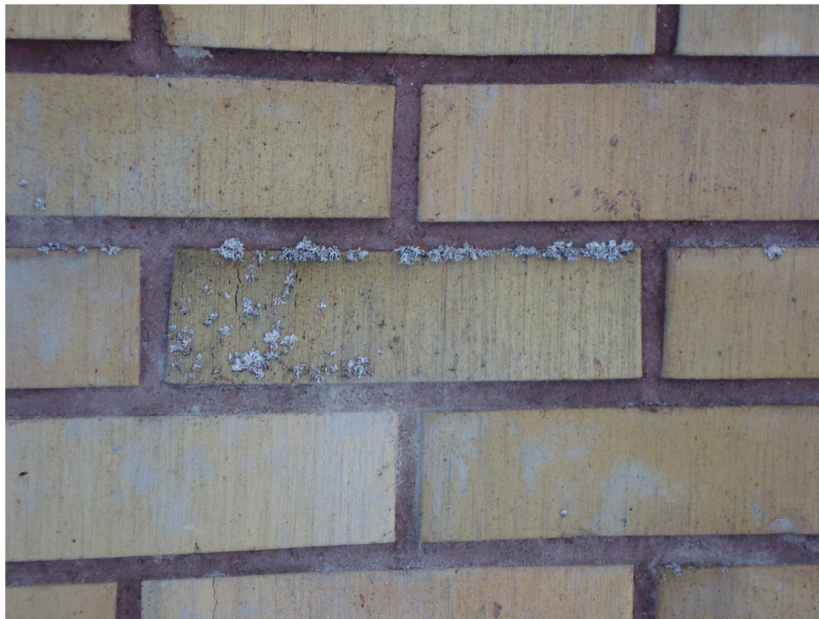
Kuva 2: Tiiliverhouksessa sammalta
