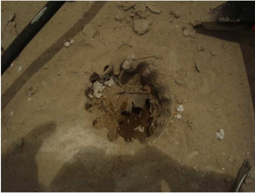
Kuva 8: Betonilaattaan tehty reikä
