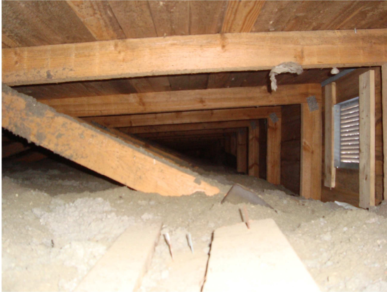
Kuva 10: Yläpohja ja tuuletusraot
