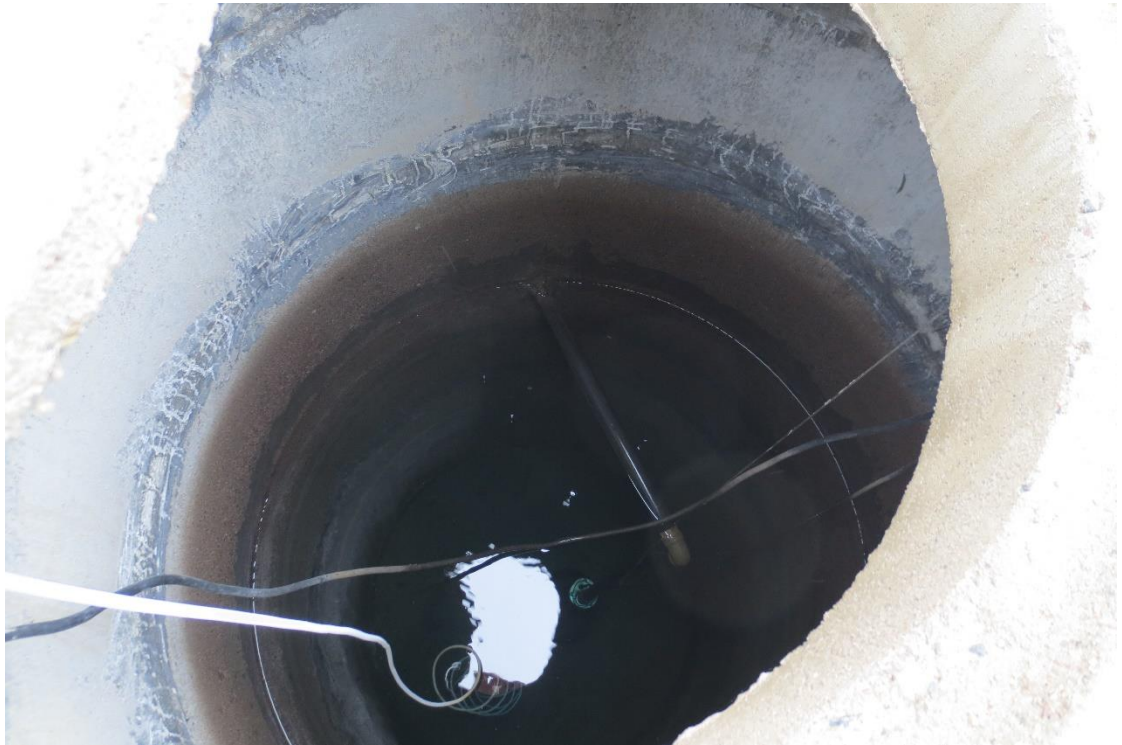
KUVA 2. Ylemmät kaivonrenkaat ovat hyvin tiivistetyt. Kaivo on sisältä puhdas ja hyvässä kunnossa (Satomaa 2014).
