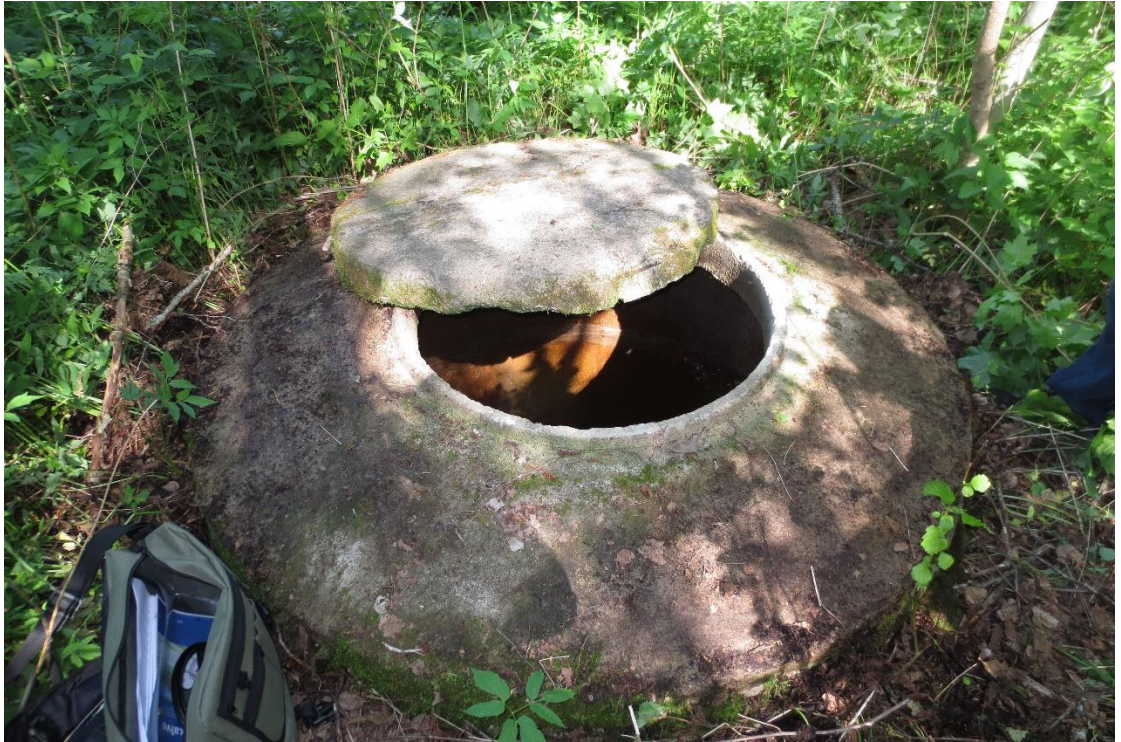
KUVA 8. Tiheässä metsässä sijaitseva kaivo, joka on altis puiden ja pensaiden juuristojen aiheuttamille haitoille. (Satomaa 2014.)
