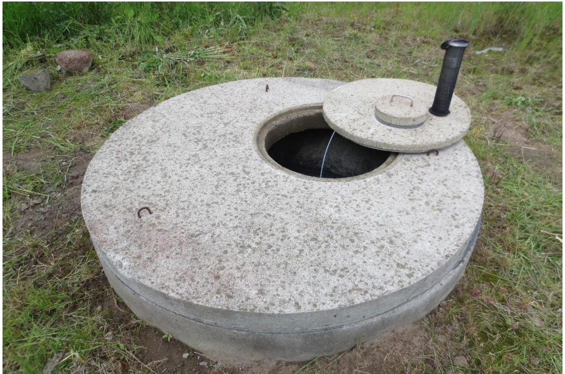
KUVA 3. Hyvin rakennettu kaivon kansi, joka on riittävän korkealla maanpinnasta. Kannen materiaali on betoni ja jossa on huoltoluukku sekä tuuletusputki (Satomaa 2014).
