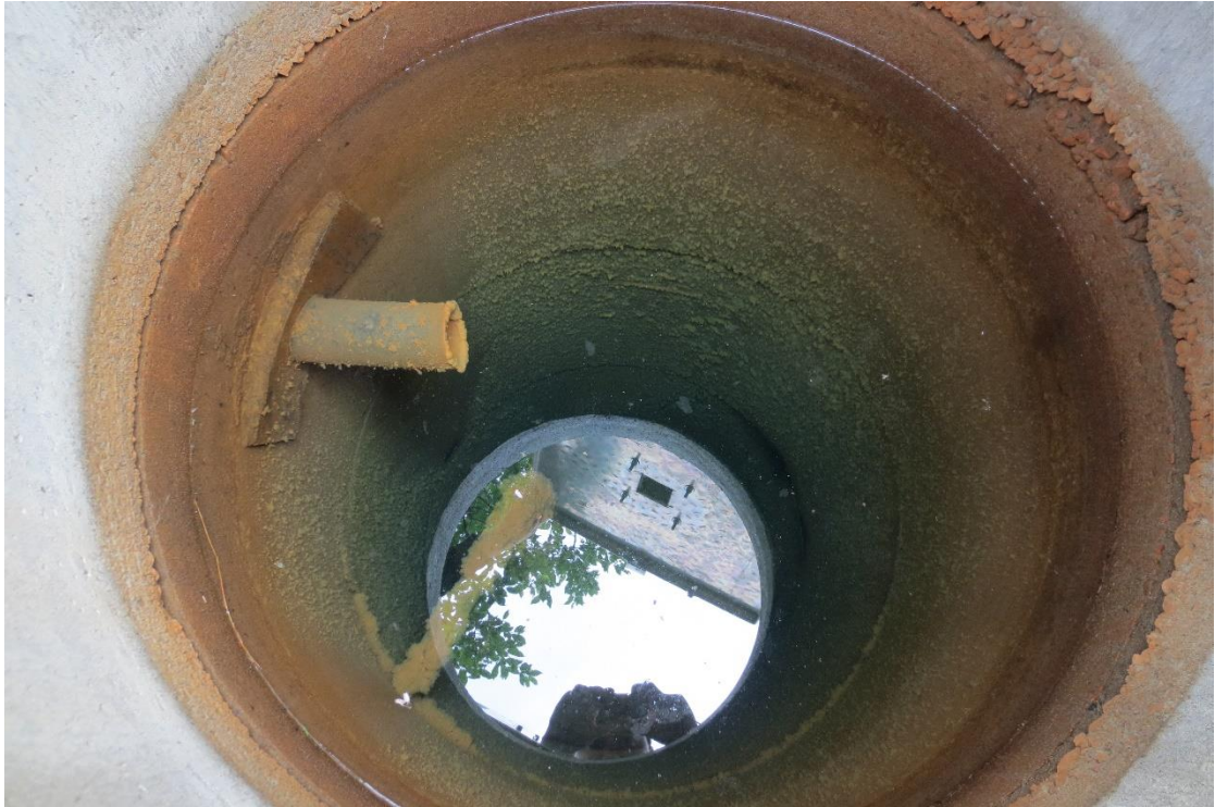
KUVA 6. Puhdistuksen tarpeessa oleva kaivo (Satomaa 2014).
