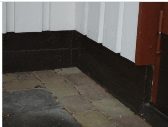
4. Sokkeli on kohtalaisessa kunnossa.
