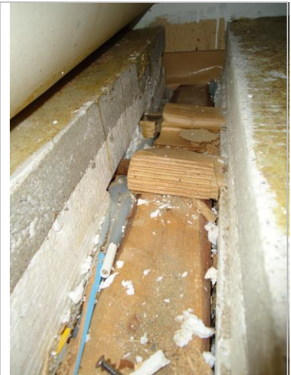
9. Ulkoseinää vasten pintalämpötilaksi mitattiin vain +5 °C.
