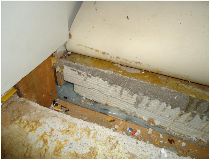
8. Makuuhuoneiden välistä puretun seinän jättämästä kuilusta todettiin kaksoisbetonilaattarakenne.
