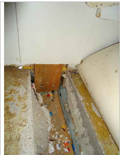
7. Väliseinärunko lähtee roskavalun päältä.
