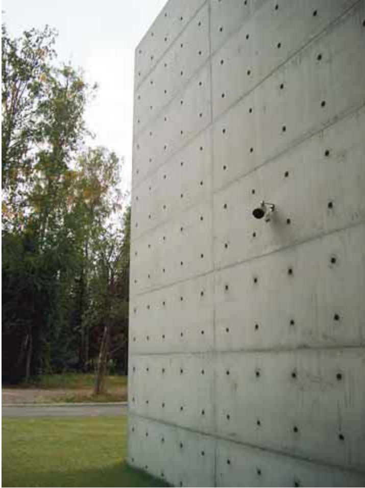
Kuva 11 It-betonilla tehty seinävalu [15.]
