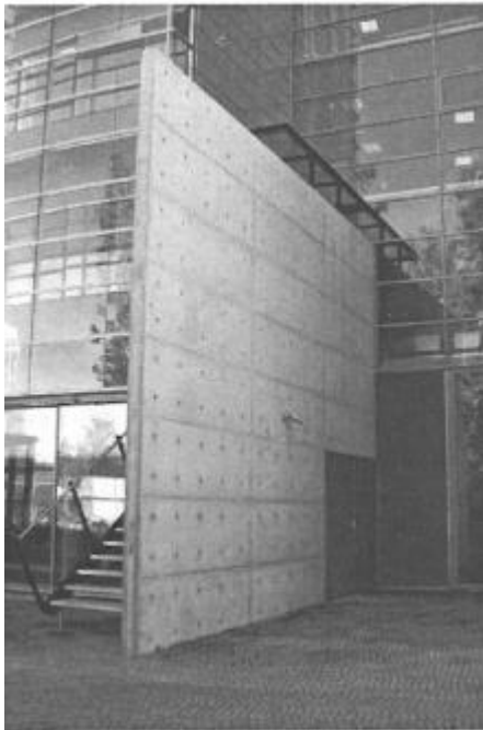
Kuva 16 It-betonilla valettua puhtasvalupintaa [14, s. 82.]
