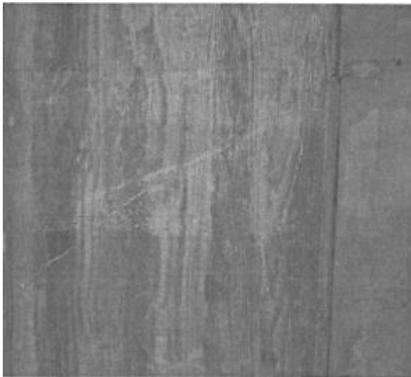
Kuva 15 It-betonilla valetun pilarin pinta. [14, s. 78.]
