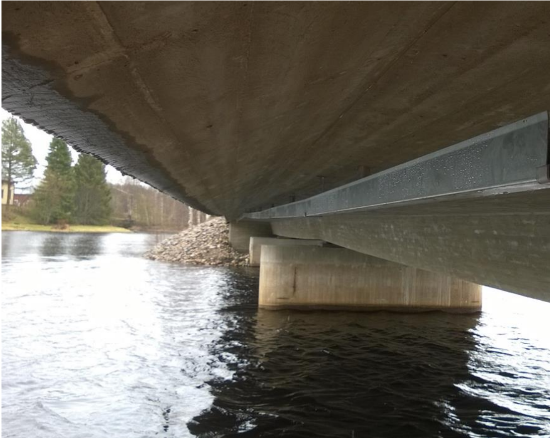
KUVA 12. Siltaan asennettu kaapelikouru
