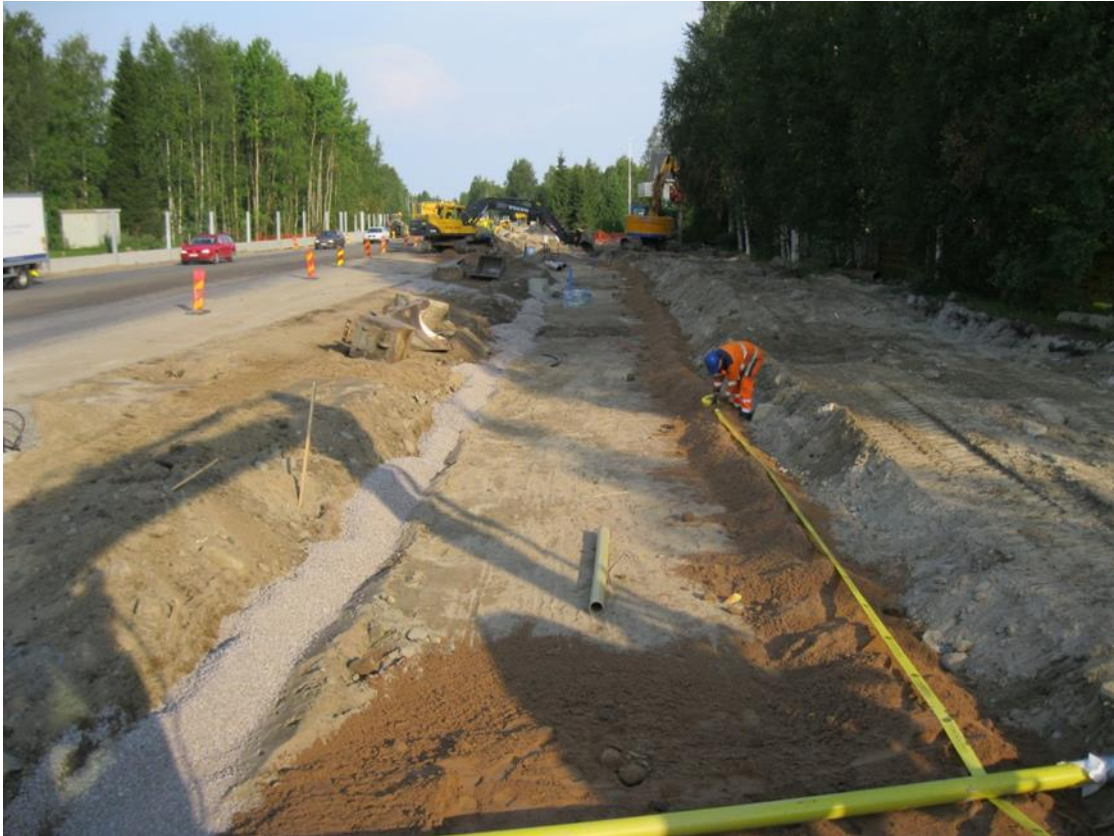
KUVA 10. Kaapelisuojanauhan käyttöä (12.)
