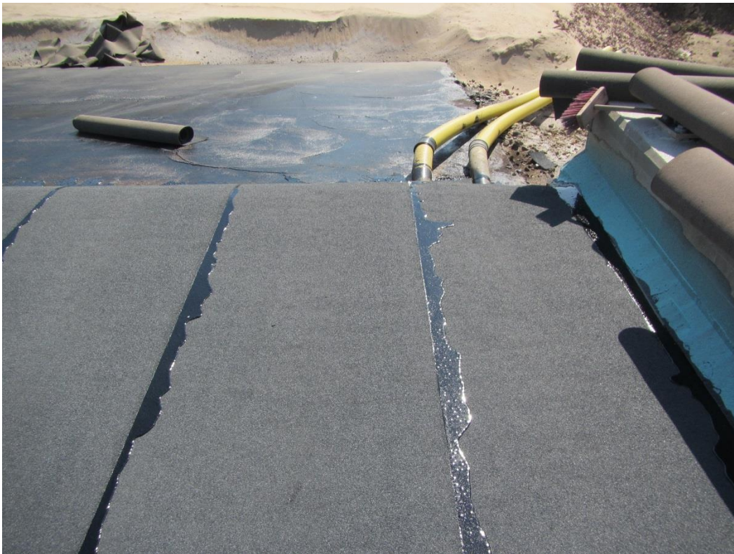
KUVA 16. Suojaputkien jatkot sillan päässä (12)
