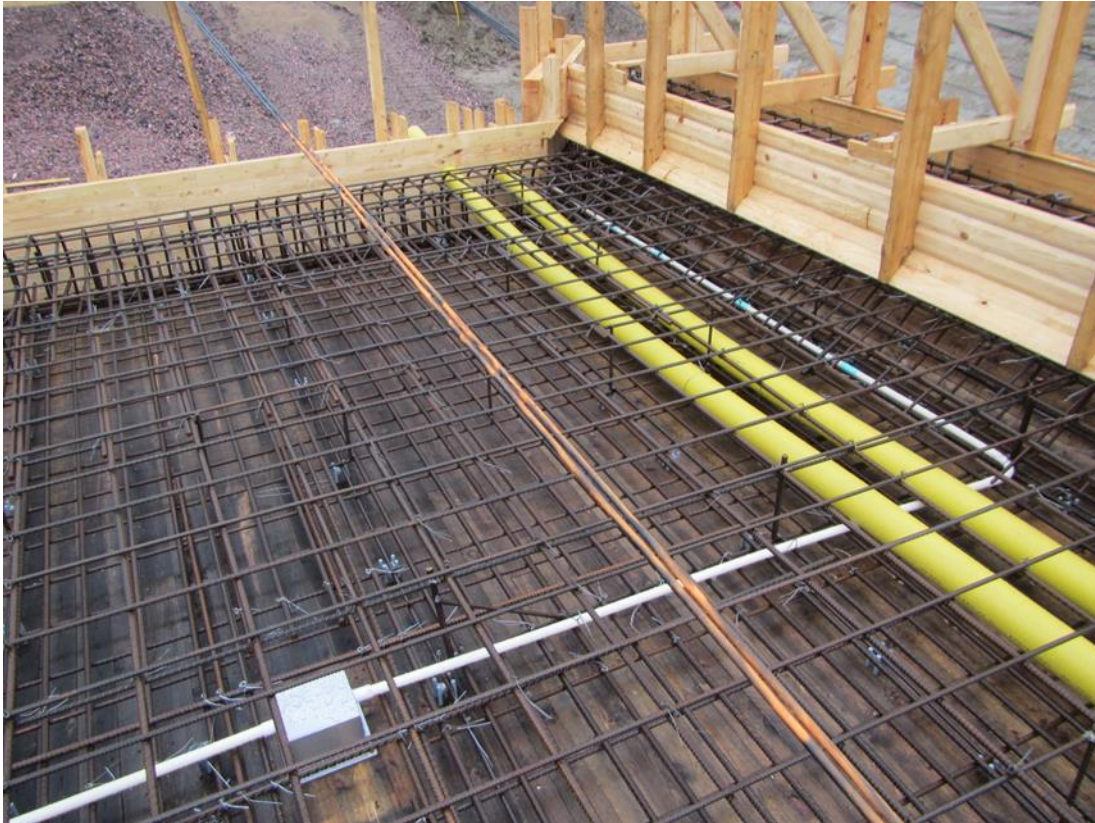
KUVA 14. Kaapeliputkia kehäsillassa (12)
