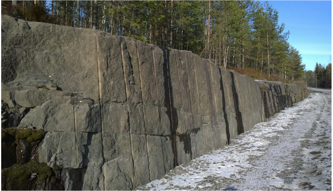
Kuva 2. Tarkkuuslouhittu kallio.
