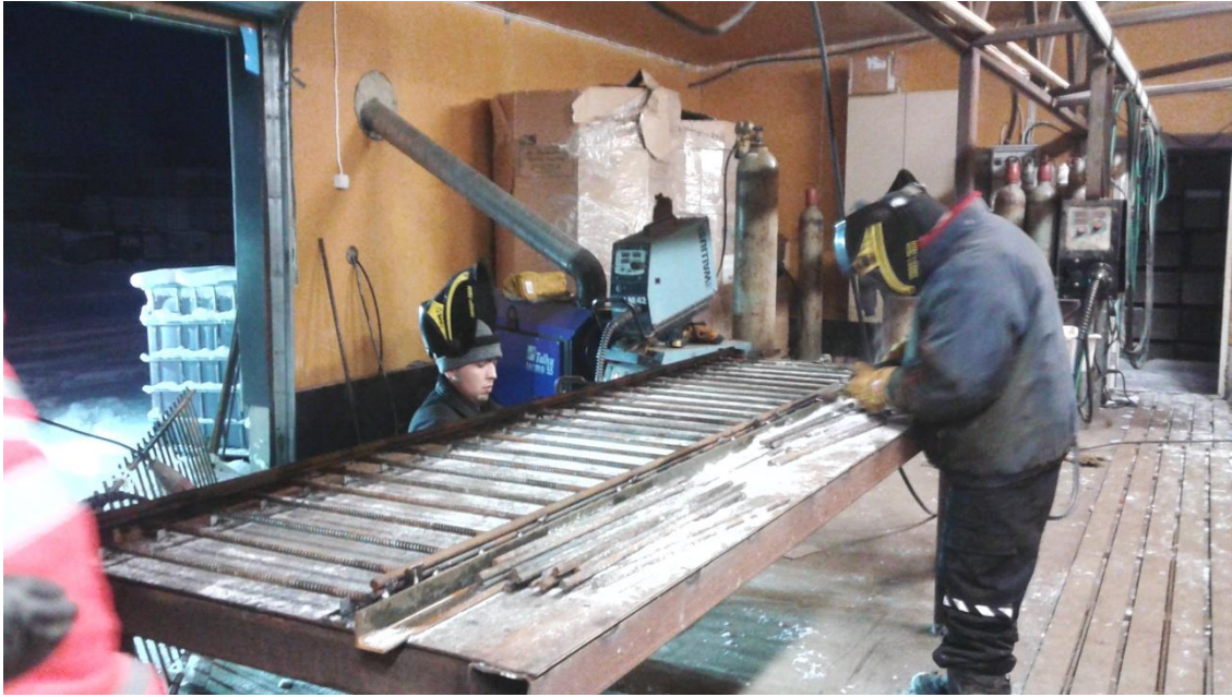
KUVA 15. Hitsauspöytä, joka keskittää elementin raudoituksen tarkasti oikeaan kohtaan toisiinsa nähden
