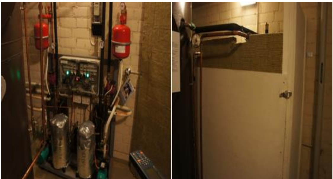
KUVA 9. Maalämpöpumppu ennen ja jälkeen vuorauksen
