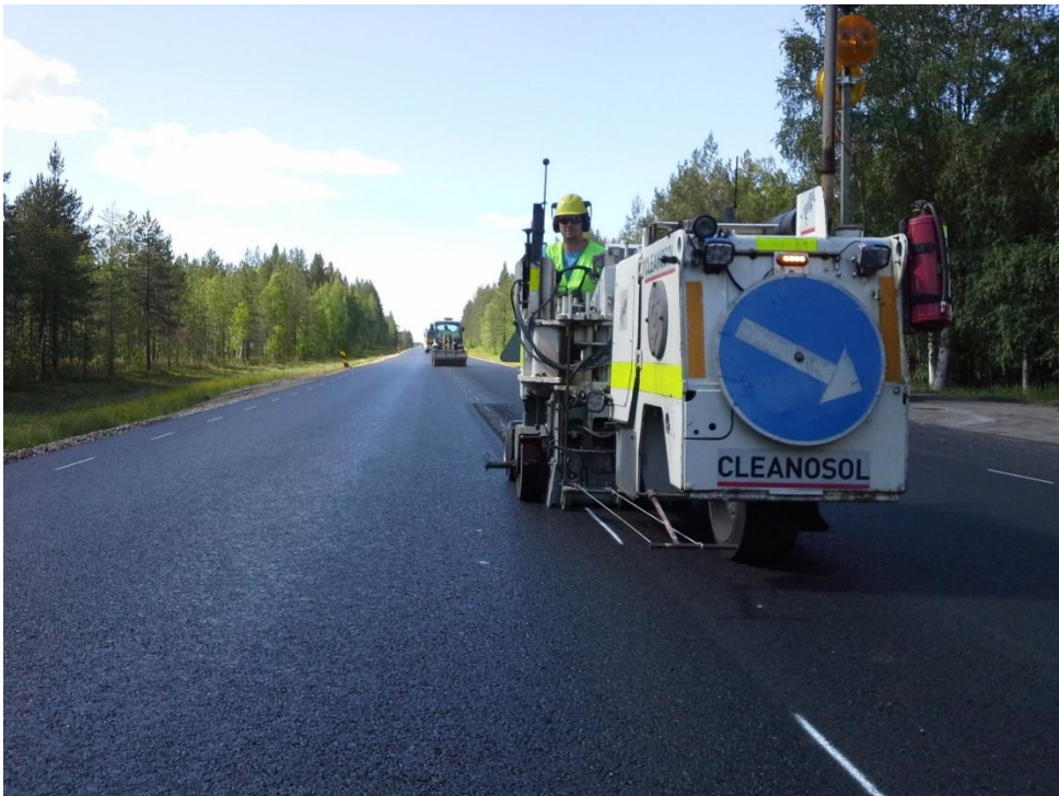
KUVA 26. Tärinäraitojen jyrsintää kaistojen väliin
