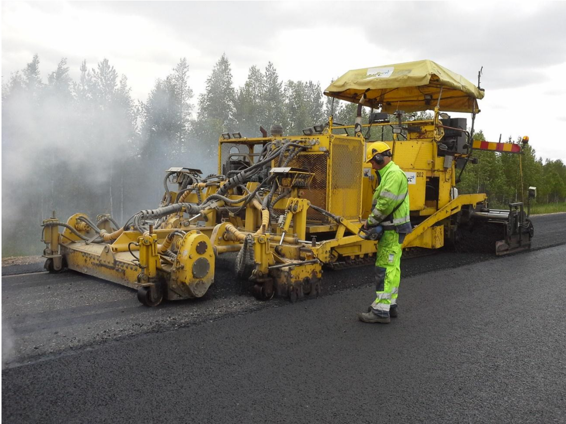
KUVA 23. Vanhan asfaltin tasausta
