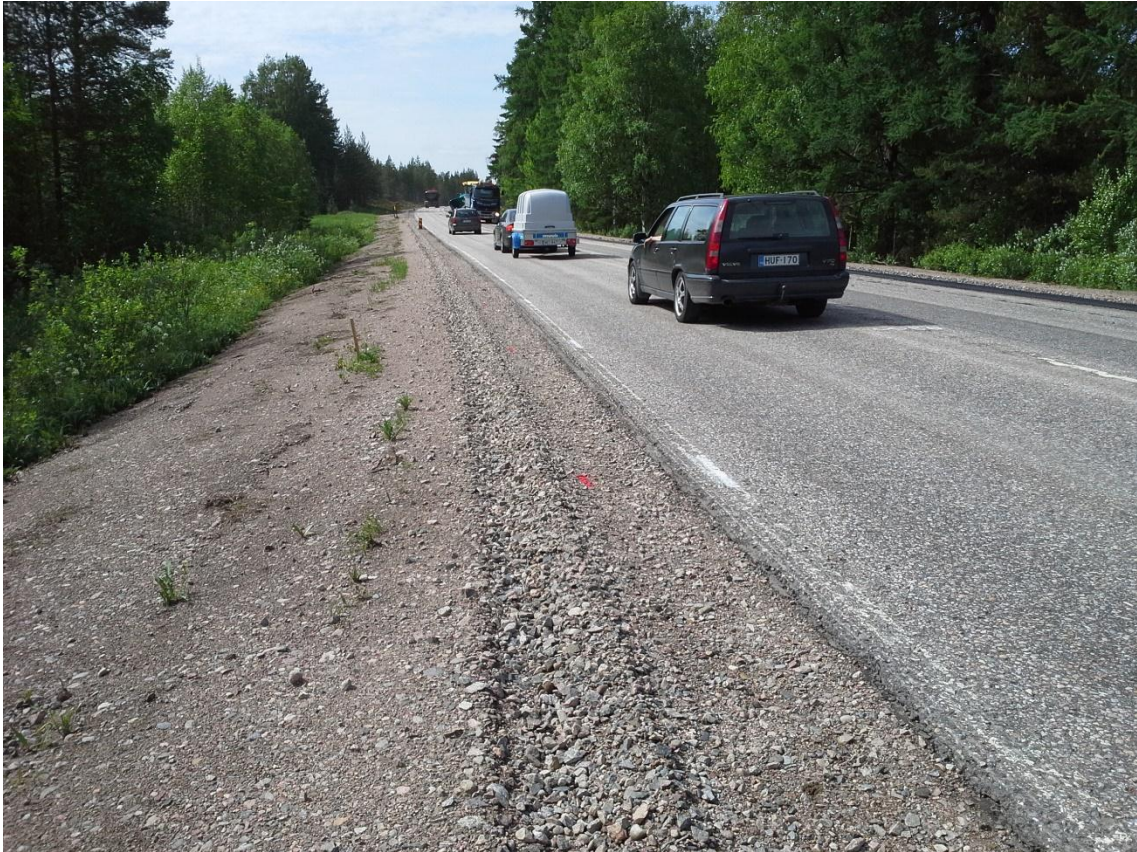
KUVA 17. Levennetty pohja odottaa asfalttia
