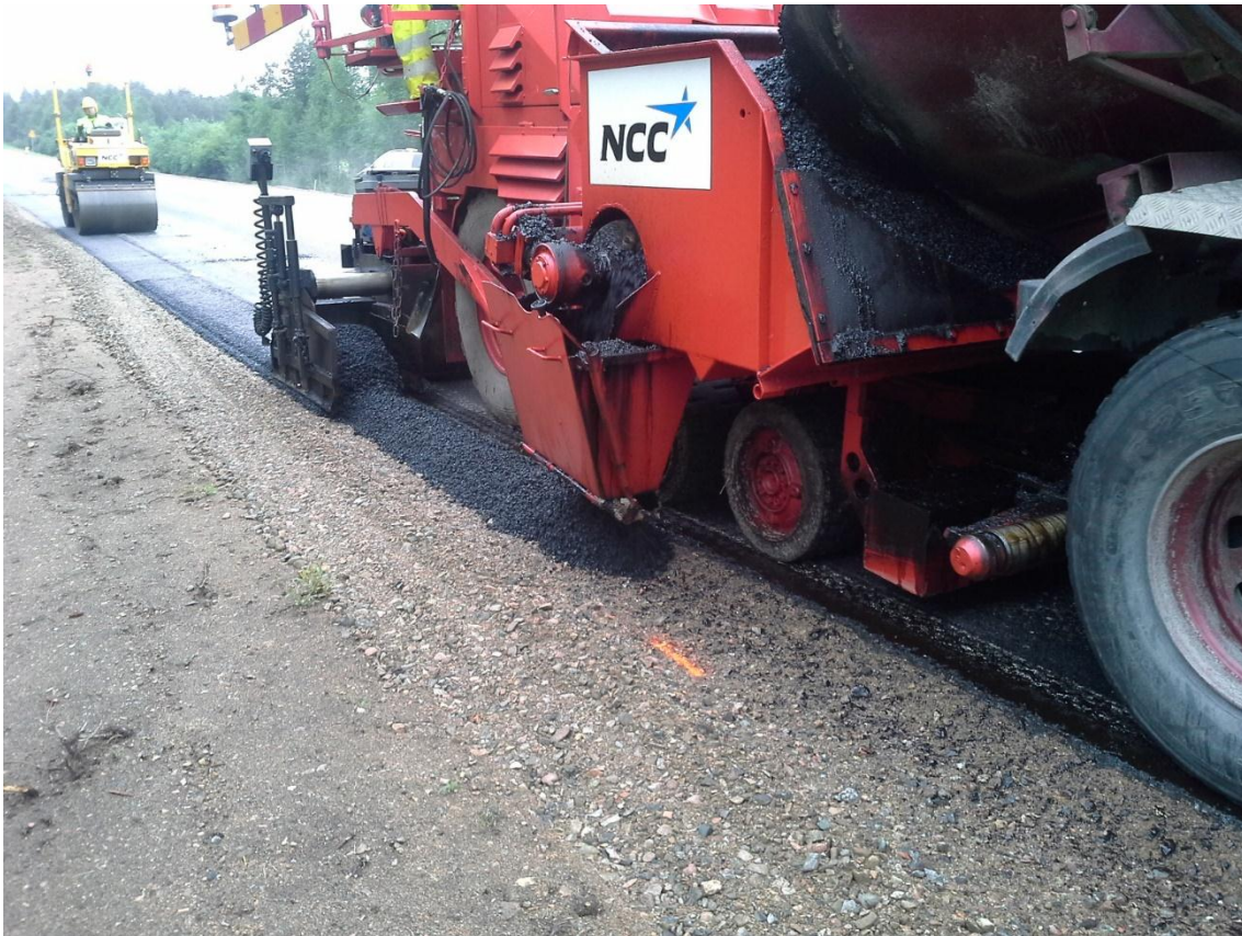
KUVA 21. Reunan levennyksen asfaltointia
