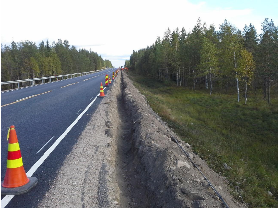
KUVA 20. Valokuitukaapelin siirto kaiteiden alta
