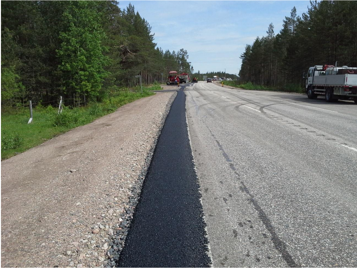
KUVA 22. Asfaltoitu reunan levennys
