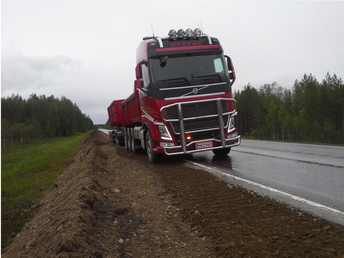
KUVA 15. Reunan levennyksen tiivistystä
