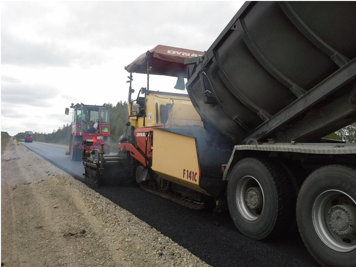
KUVA 24. Koko tien päällystystä
