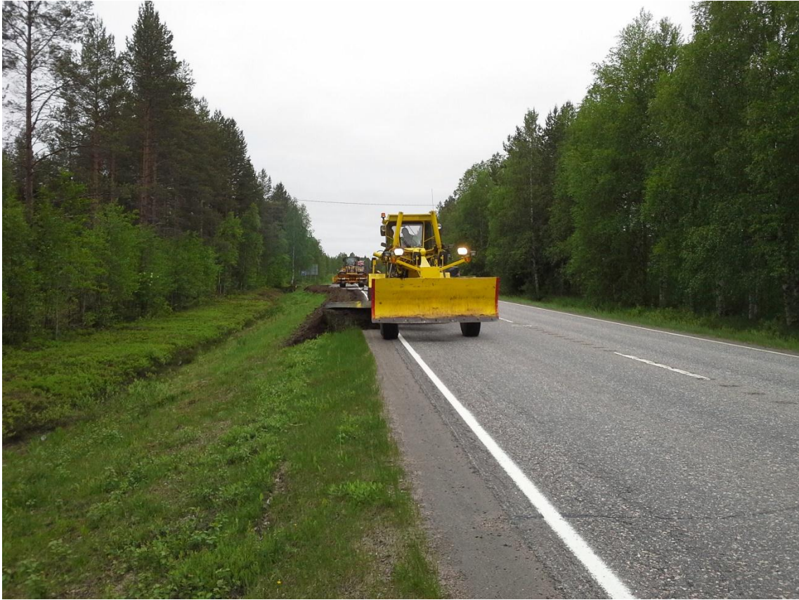
KUVA 12. Pintamaan poistaminen tiehöylällä
