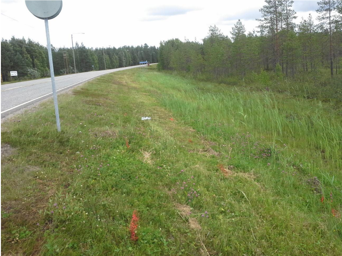
KUVA 19. Kaapelit merkitty siirrettävän liikennemerkkin läheltä
