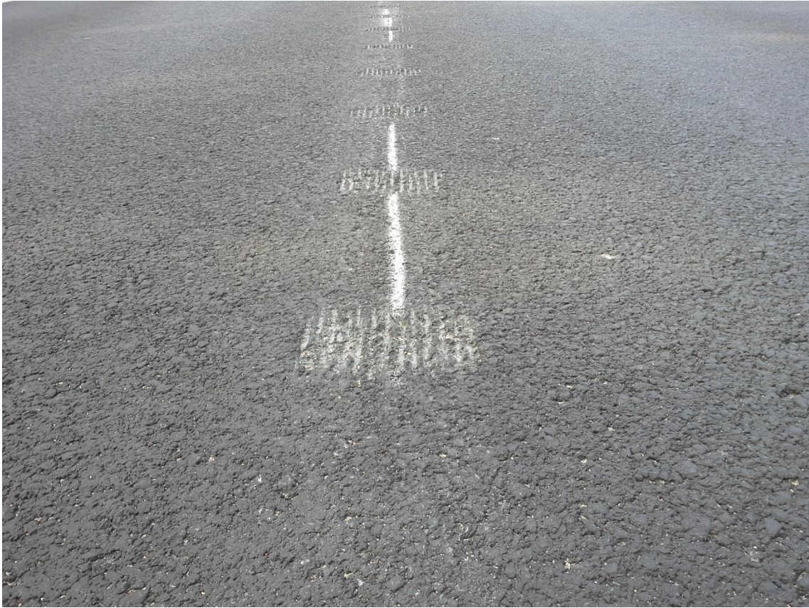
KUVA 27. Valmiit tärinäraidat kaistojen välissä
