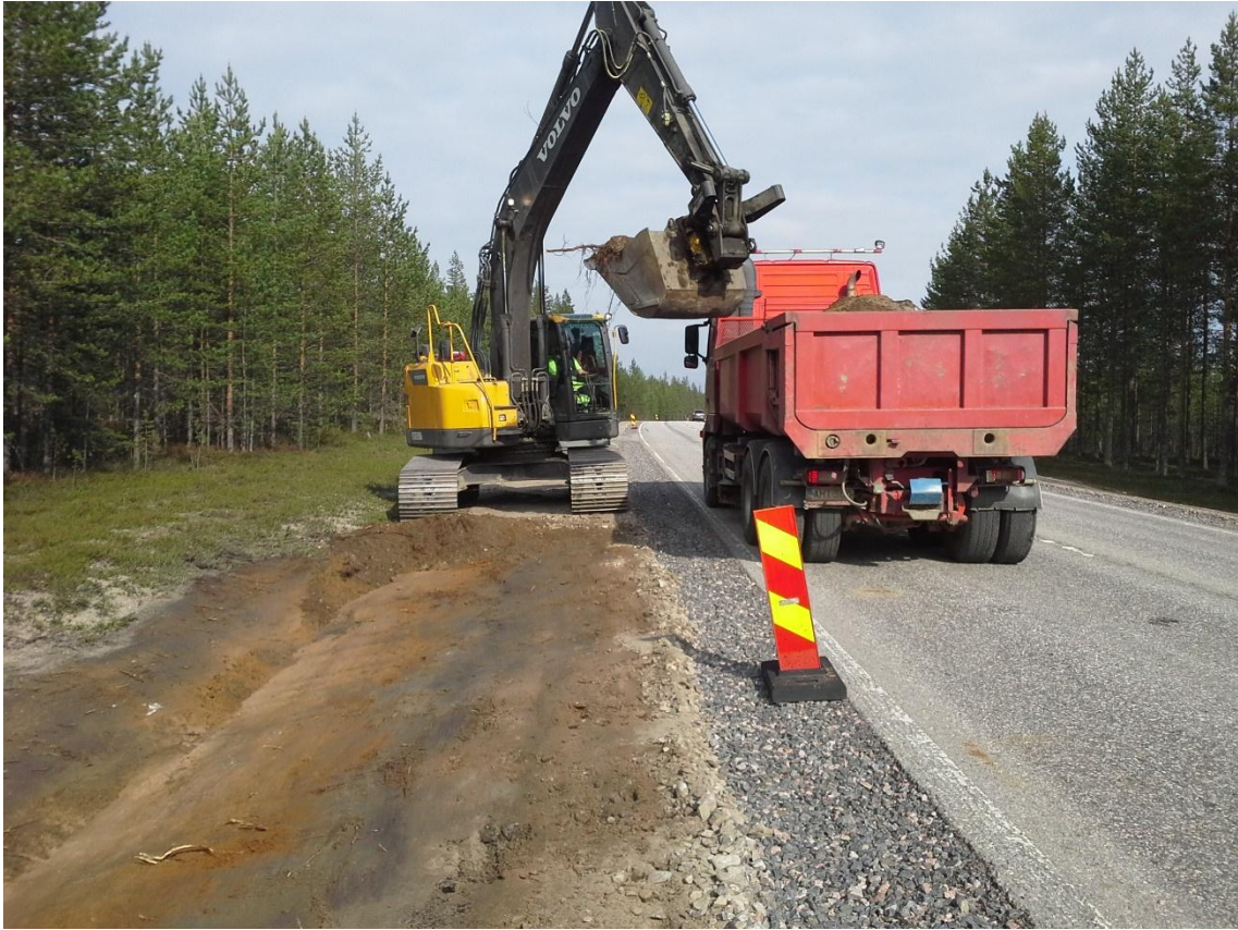
KUVA 18. Ojan kaivua levennyksen yhteydessä
