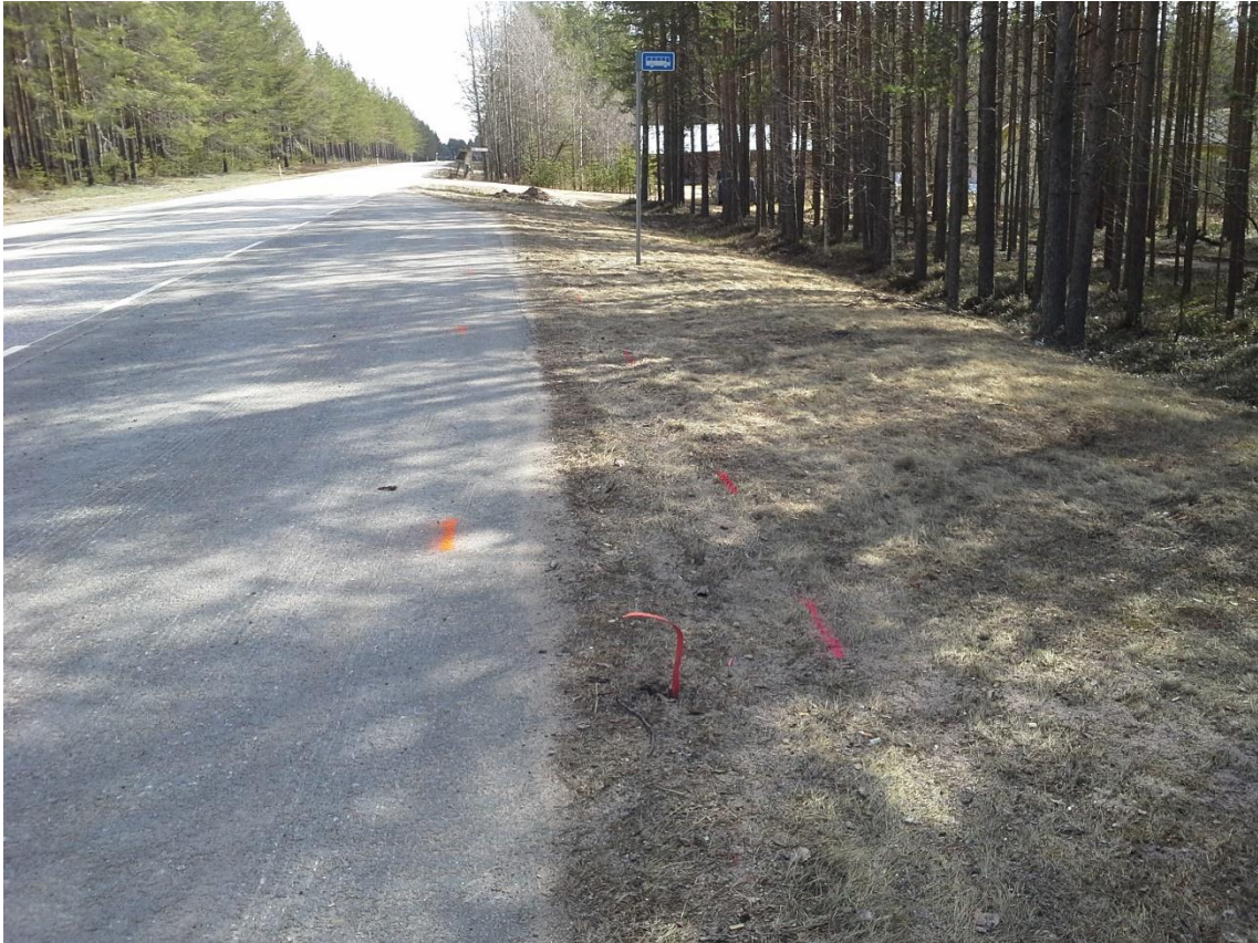
KUVA 10. Tietoliikennekaapelit lähellä päällysteen reunaa ja päällysteen alla
