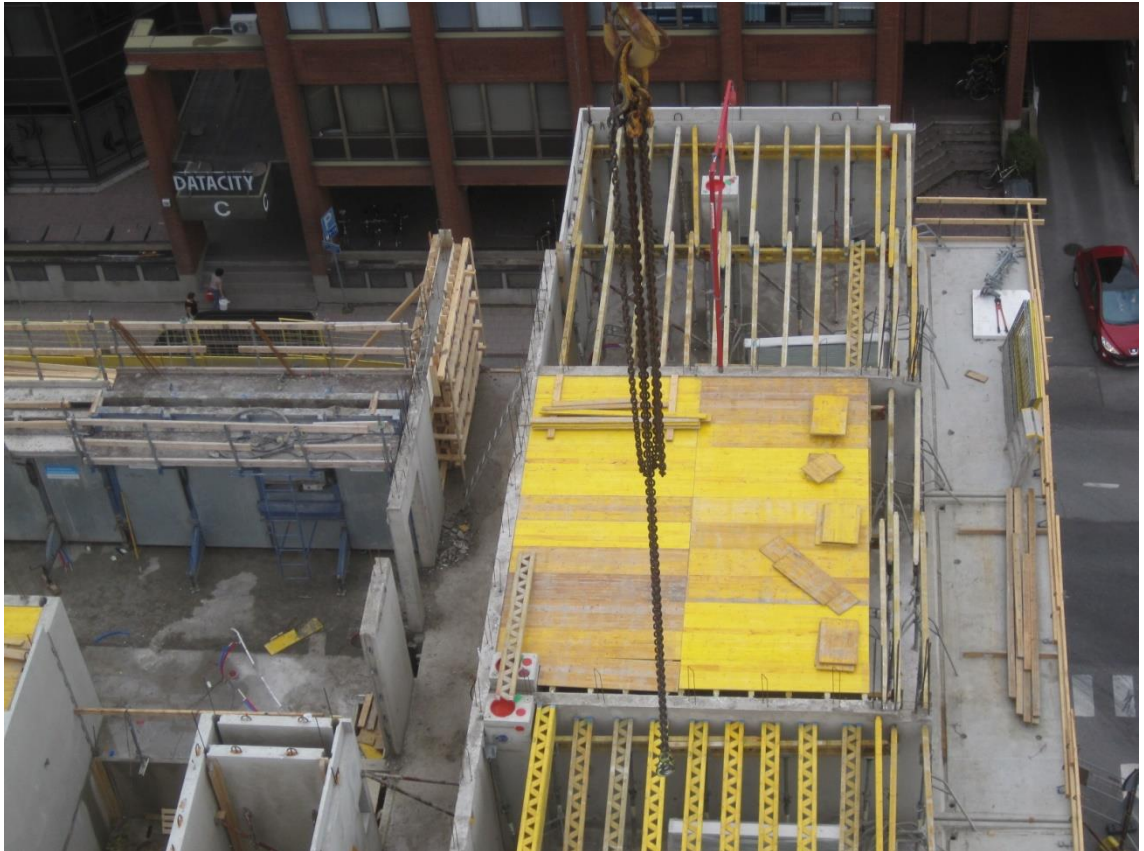
Kuva 4. Kolmannen valupäivän jälkeen. Osa holvista laudoitettuna.
