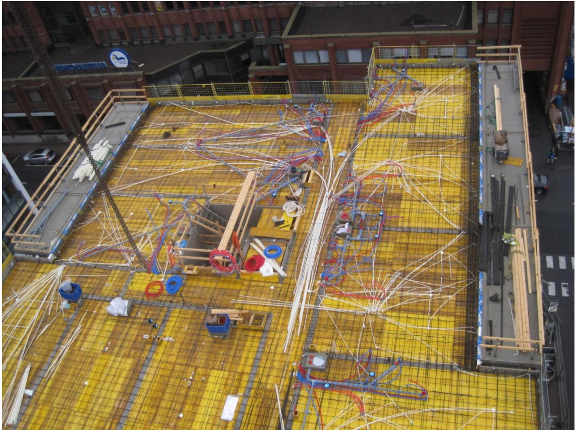
Kuva 8. Seitsemäntenä päivänä suurin osa talotekniikasta asennettuna.
