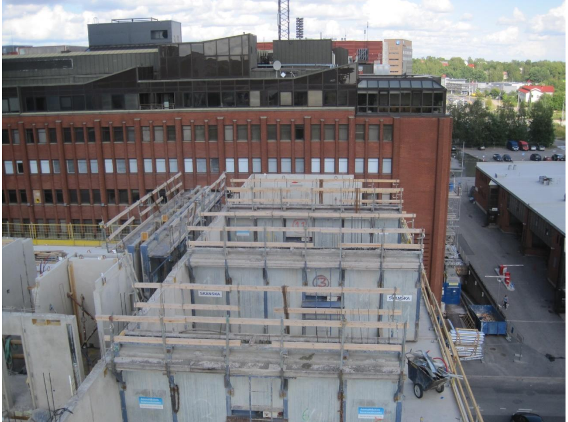
Kuva 3. Toisen valupäivän jälkeen. Osa elementeistä jo asennettuna.
