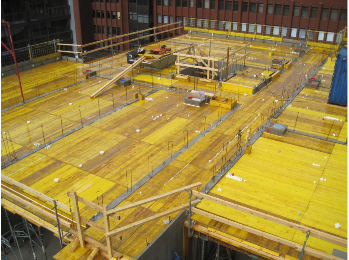
Kuva 6. Viidennen päivän jälkeen holvi on laudoitettu.
