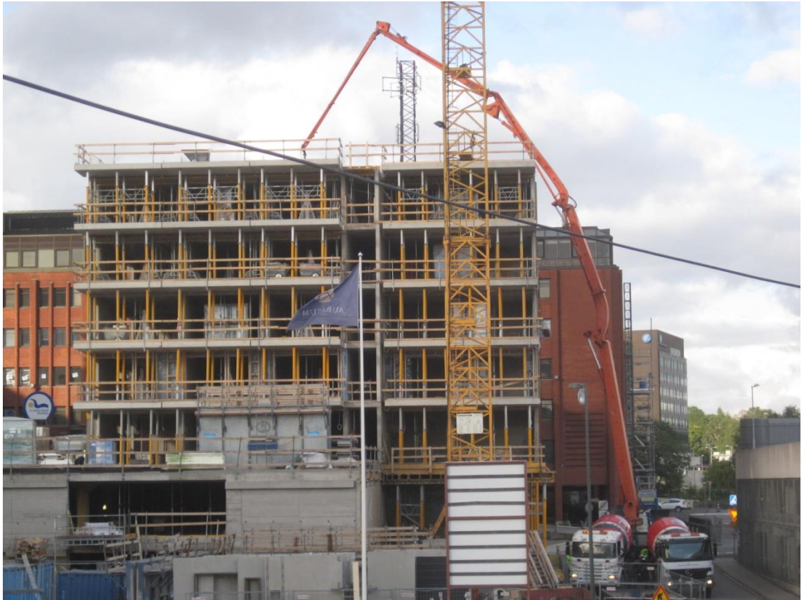
Kuva 9. Holvin valu käynnissä.
