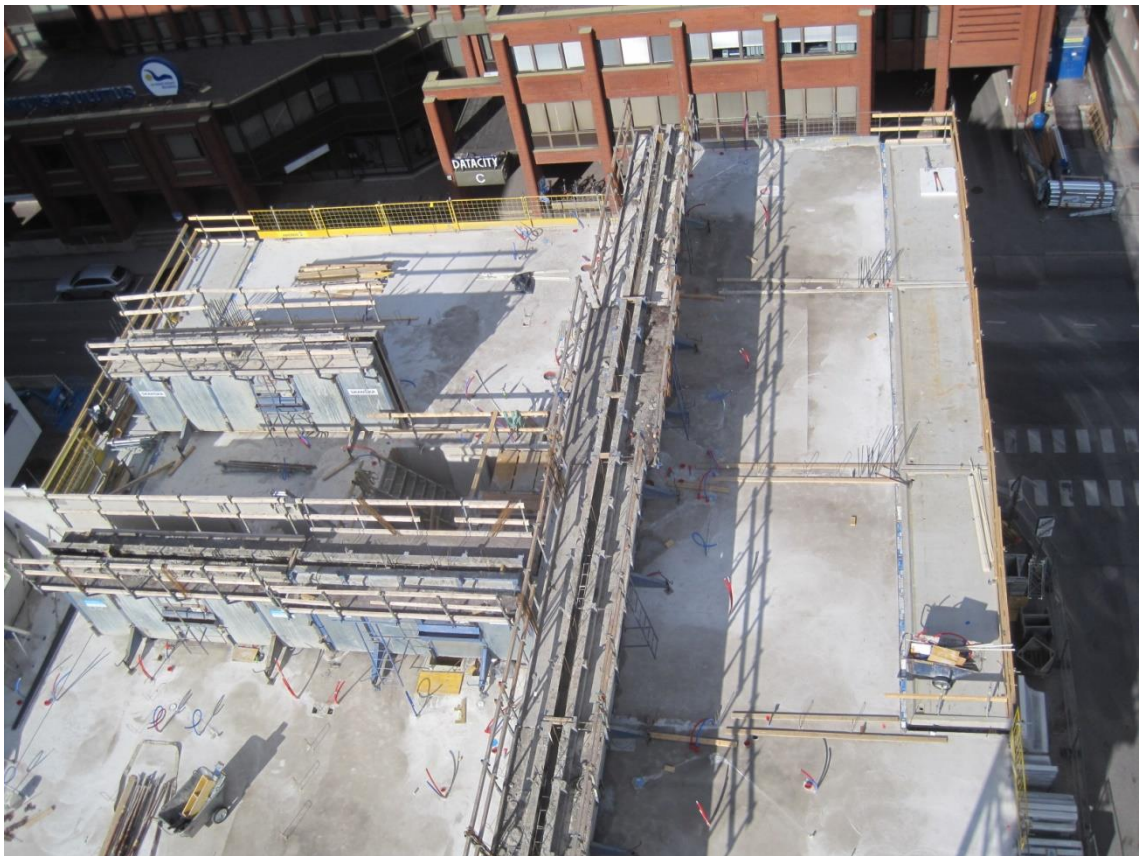
Kuva 2. Ensimmäisten seinävalujen jälkeen.
