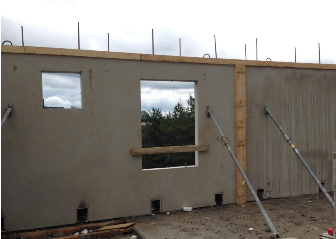
KUVA 12. Elementeistä pystytetty seinä valmiina ontelolaattoja varten
