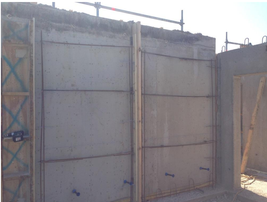
KUVA 7. Tuplausta vaille valmis oleva muotti
