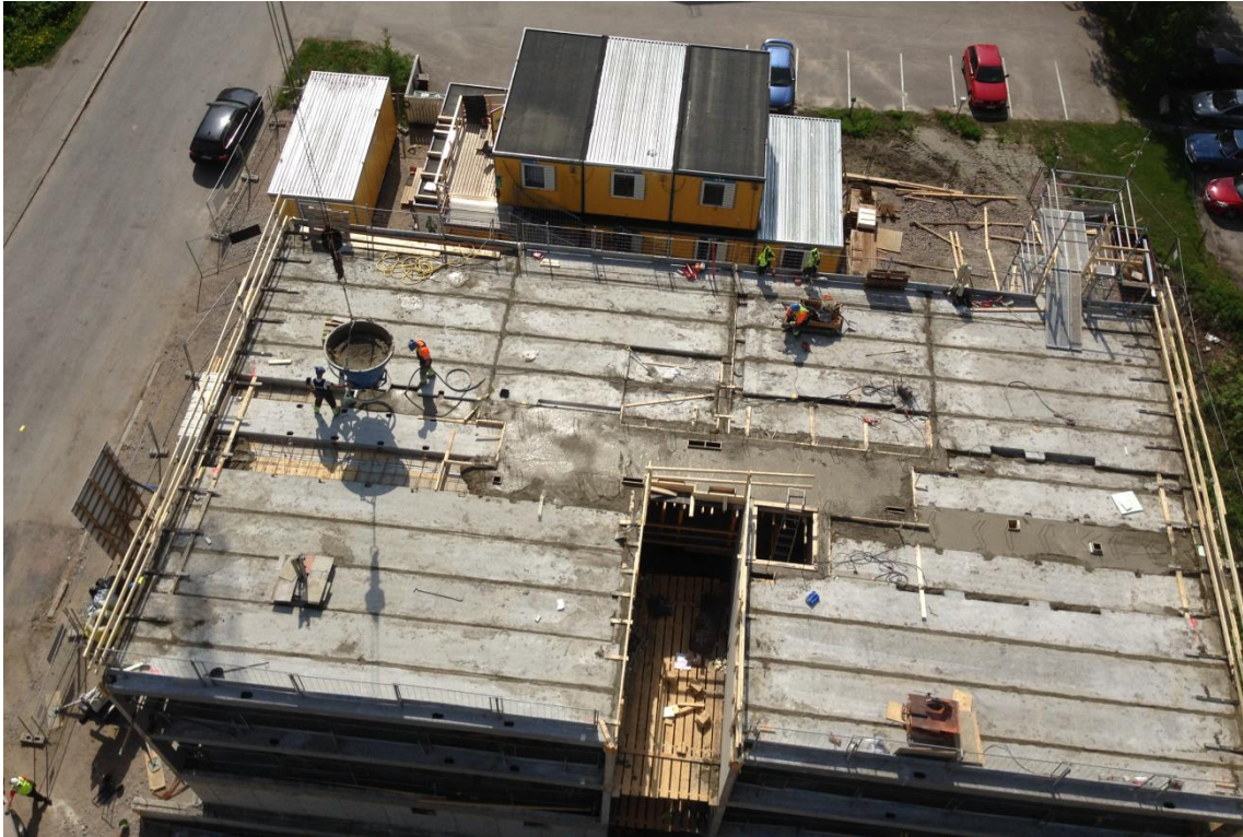
KUVA 11. Holvin valutyö, ontelolaatan saumavalu tehty ja paikallavalukaistat loppuillaan
