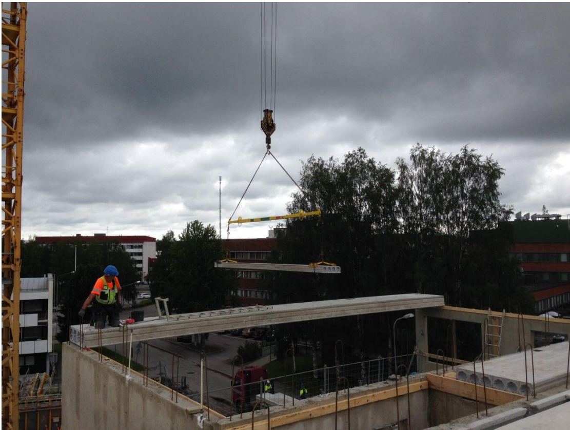
KUVA 9. Ontelolaattojen asennus ja valustoppareiksi asennetut laudat
