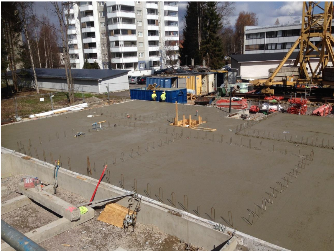
KUVA 3. Maanvaraisen laatan valu ja seinän tartunnat
