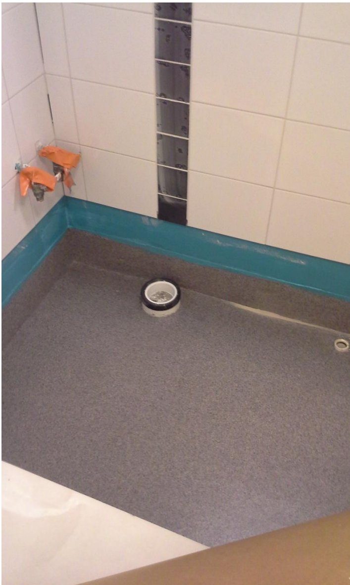
KUVA 13. Valmis kylpyhuoneen akryylibetonilattia
