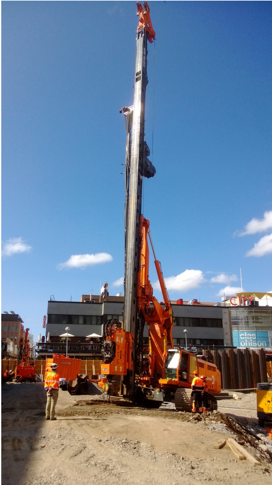
KUVA 11. Itse sekoituskone oli tyypiltään RTG 25
