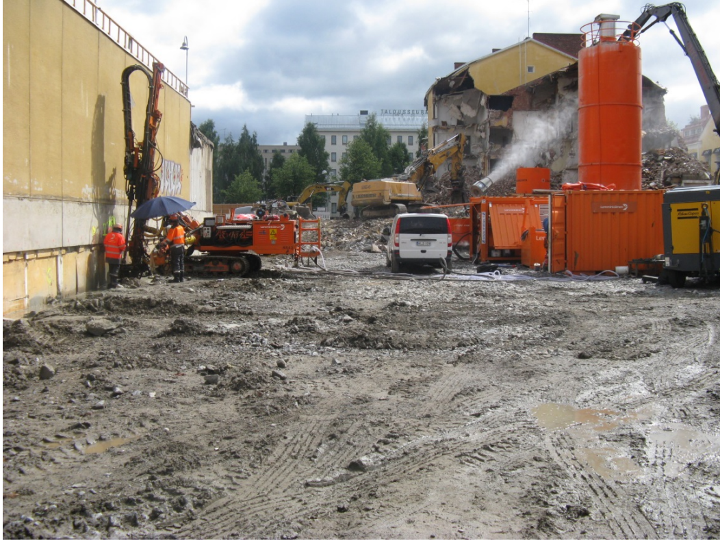
KUVA 10. Valkean työmaan suihkupaalutuskalustoa
