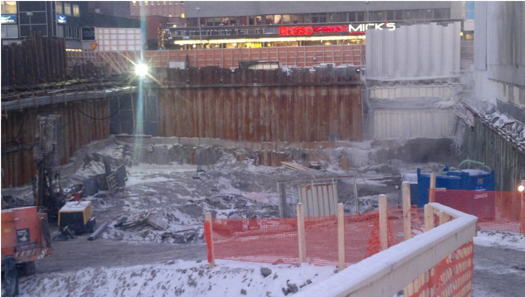
KUVA 7. Kauppakeskus Vakelan työmaa Oulun keskustassa
