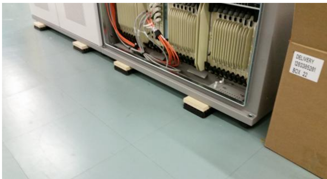
Kuva 24. Herkän laitteen tärinäeristys
