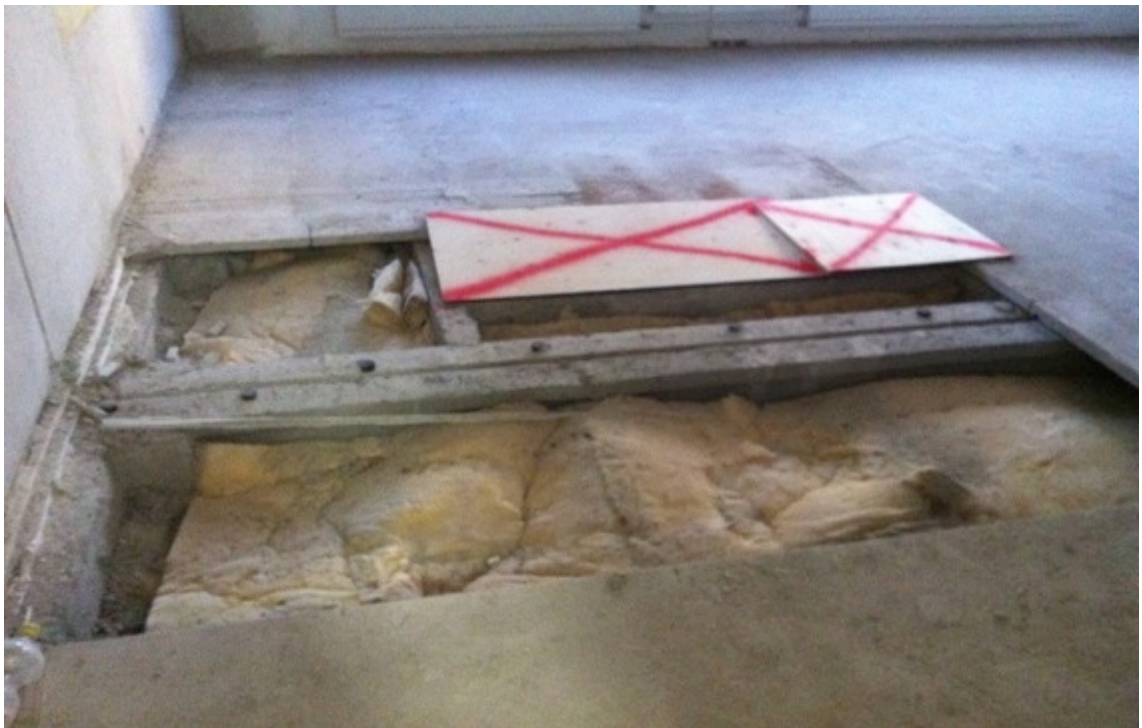
Kuva 6. Kotelolaatan rakenne pintalaatan poistamisen jälkeen.
