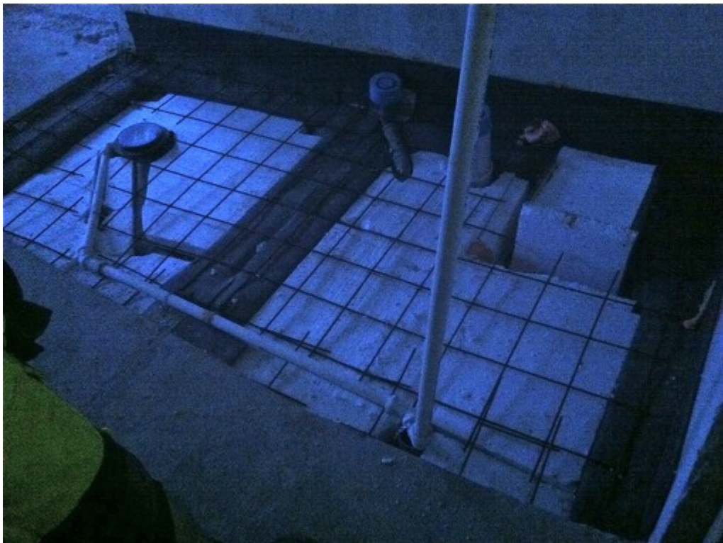
Kuva 5. Uuden yksiön viemärihajotukset Nilcon-palkistossa ennen lattiavalua.
