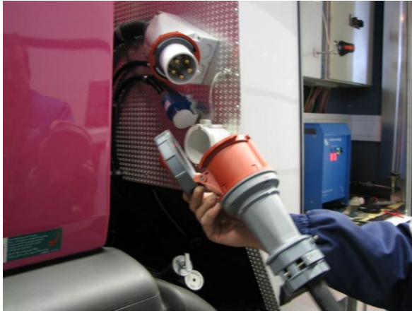
KUVA 9. Sähkösyötön autonpuoleinen liitäntä
