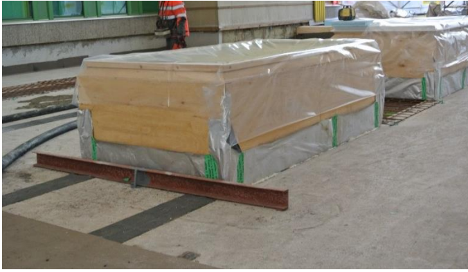
KUVA 26. Uudet kattoikkunat, joiden väliin jää umpeen laitettava kattoikkunaukko 2.4.2015
