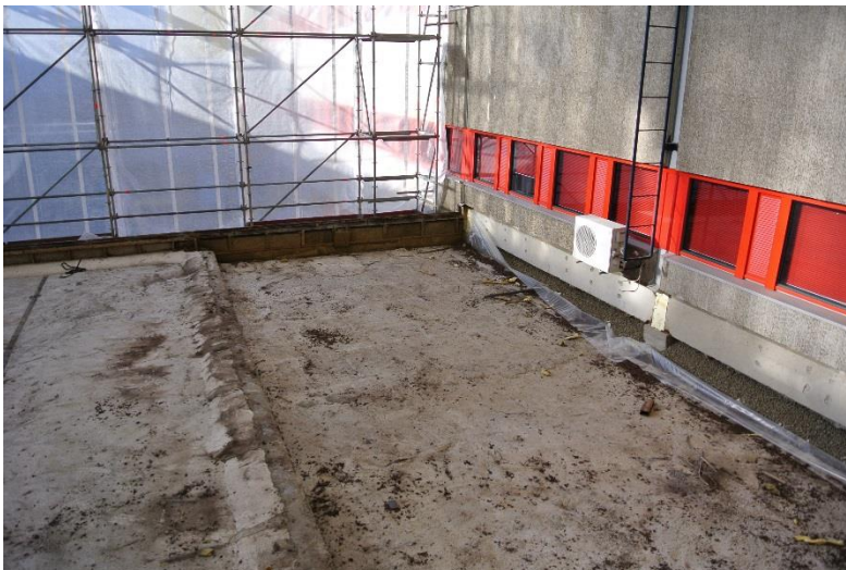
KUVA 30. Rakennusvaiheiden I ja IV rajapinta vesikaton rakenteiden purkutöiden jälkeen 17.4.2015
