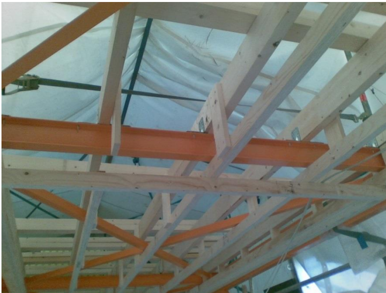
KUVA 16. Yhdyskäytävän yläpohjan peruskorjaus vuonna 2010 (Hyvärinen 2015)
