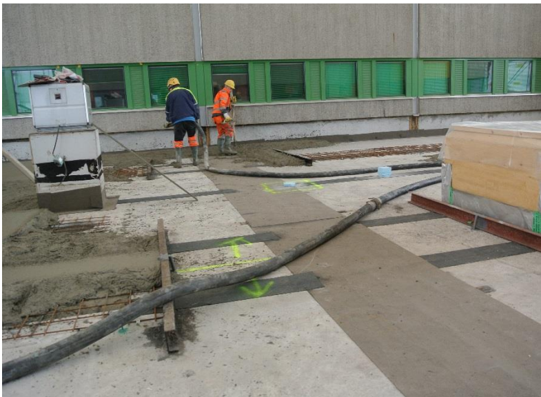
KUVA 27. Valutyöt ja poistettu liikuntasauva 2.4.2015
