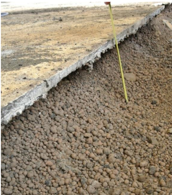
KUVA 21. Pintalaatta ja eristekerros 17.3.2015
