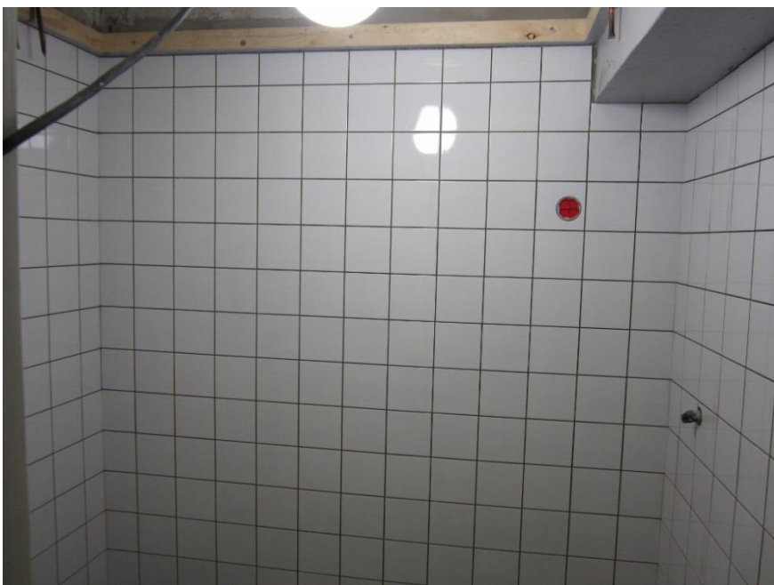
Figur 11. Plattsättning av vägg 11
