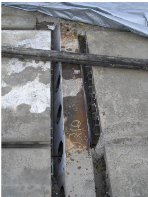
Figur 6. En ännu inte fastgjuten anslutning mellan deltabalk och hålplattor.
