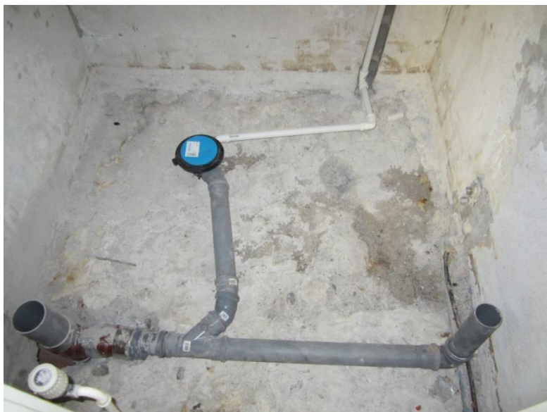
Figur 4. Montering av plastavlopp 4
