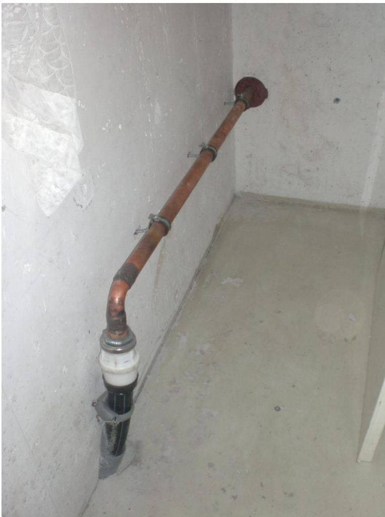
Figur 22. Ny inkommande vattenledning (insidan) 22
