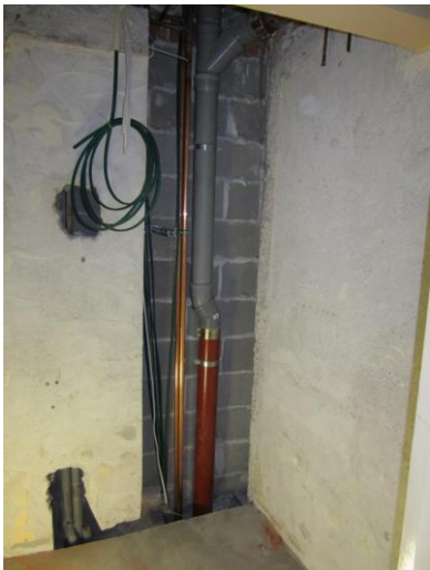
Figur 7. Förnyade avlopp och vattenstigare i befintligt schakt. I detta fall öppnades befintligt stigarschakt som för övrigt var placerat mellan två badrum på varje våning, således kunde man utan att offra utrymme få nya bruksvattenrör samt avlopp till två badrum per våning med att enbart öppna väggen i ena badrummet. I samma schakt fick man också datakabel.
