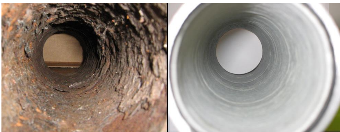
Figur 13. Före och efter bild, ny beläggning genom sprutgjutning 43
