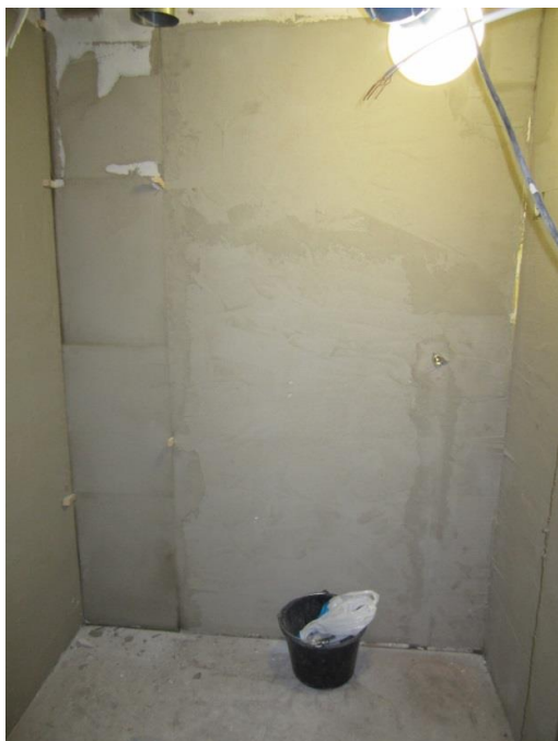
Figur 8. Schaktet igenmurat och golvet gjutet 8
