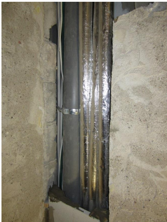
Figur 6. Montering av nya rör 6
