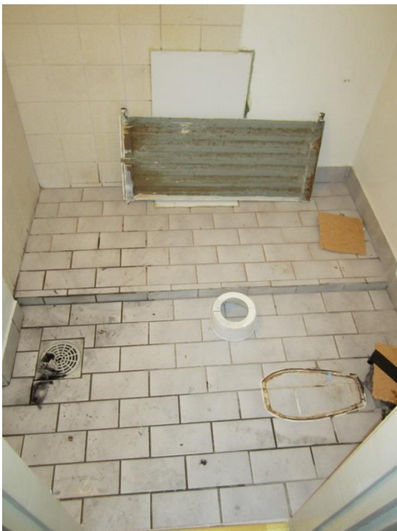
Figur 2. Demontering av badrum 2
