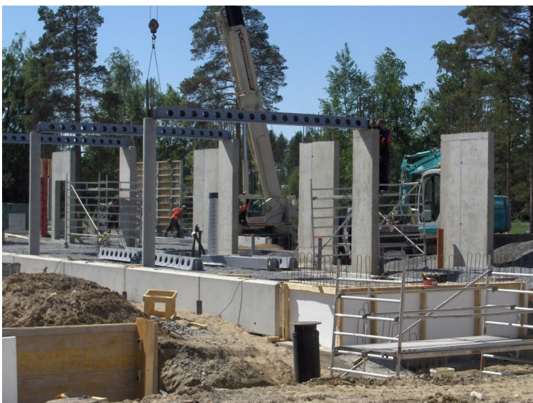
Figur 4. Montering av deltabalkar, deltabalkarna håller upp hålbjälklaget.
