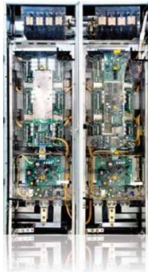
SAMI STAR -vaihtosuuntaajayksiköt (yllä) ennen jälkiasennusta ja uudet ABB:n teollisuustaajuusmuuttajat, jotka on asennettu SAMI STAR -kaappeihin (alla).
