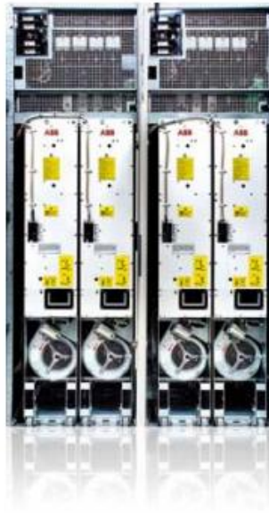
SAMI STAR -vaihtosuuntaajayksiköt (yllä) ennen jälkiasennusta ja uudet ABB:n teollisuustaajuusmuuttajat, jotka on asennettu SAMI STAR -kaappeihin (alla).
