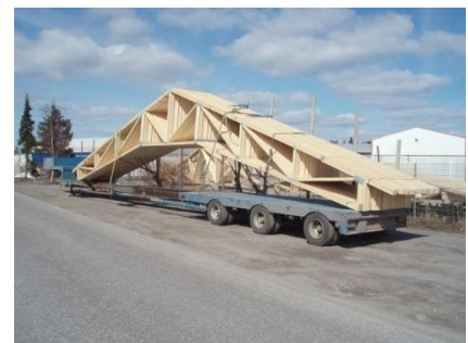
Kuva 4. NR- rakenteiden kuljetus
