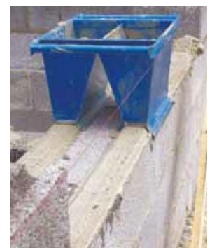
Kuva 5. Rakosauma syntyy kätevästi laastikelkalla.
