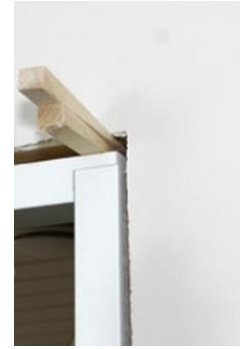
Kuva 3. Karmin säätö kiiloilla
