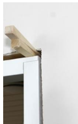
Bild 3. Kontrollera karmens lodrät med hjälp av kilarna
