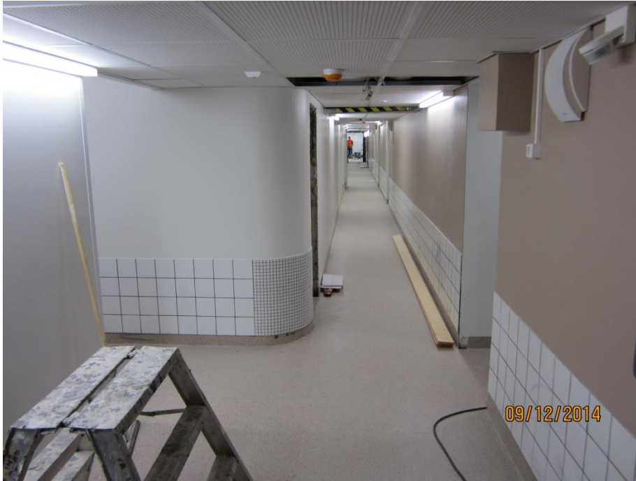
KUVA 9 Käytävän seinien alaosa laatoitettu
