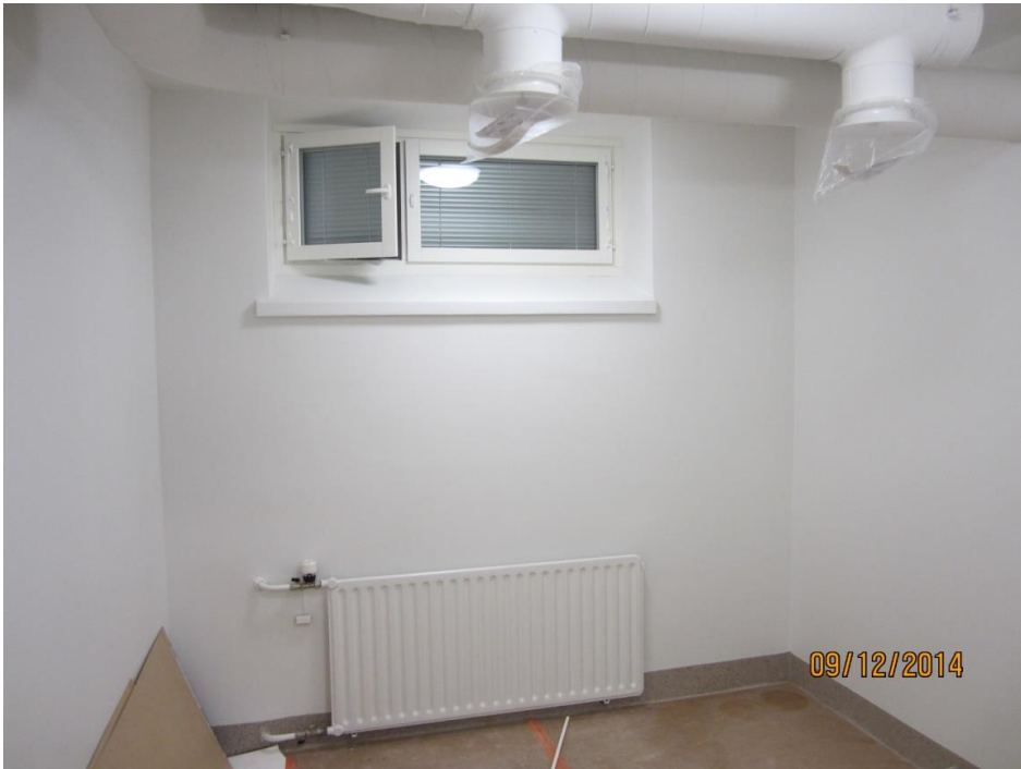
KUVA 10 Uudet ikkunat asennettuna
