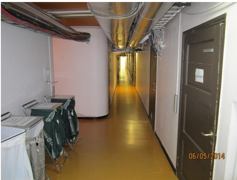
KUVA 4 Vanhanaikaiset tilat ennen remonttia
