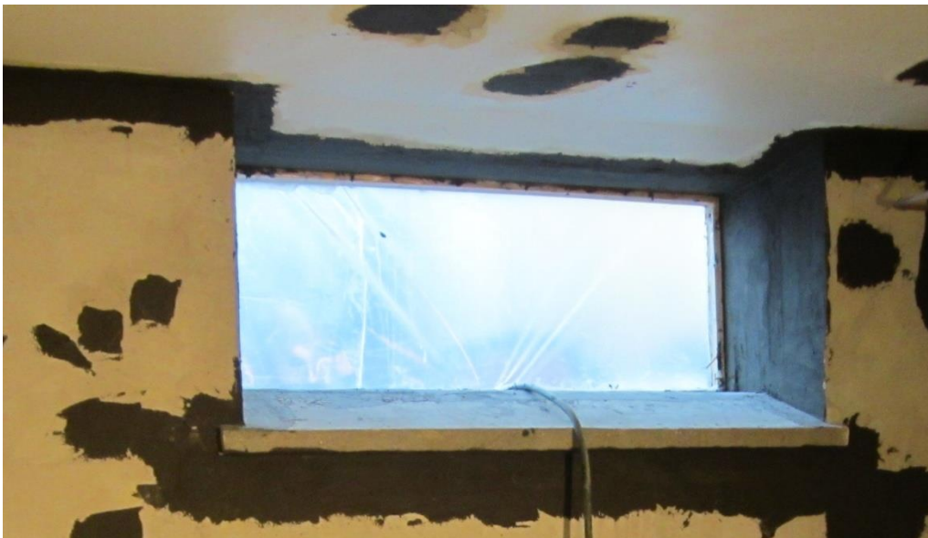
KUVA 7 Ikkuna-aukon tiivistys tehtynä
