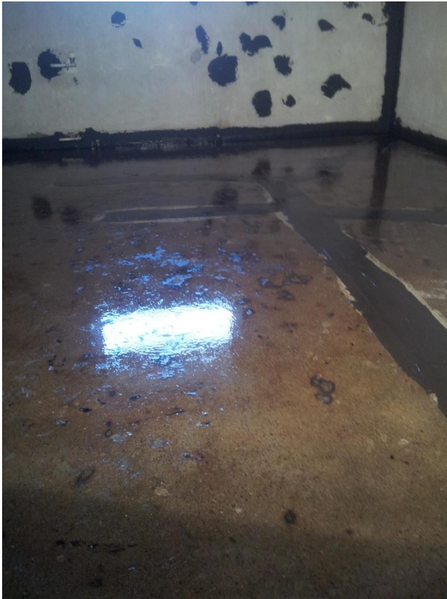
KUVA 8 Epoksihartsin ensimmäinen levitys tehty
