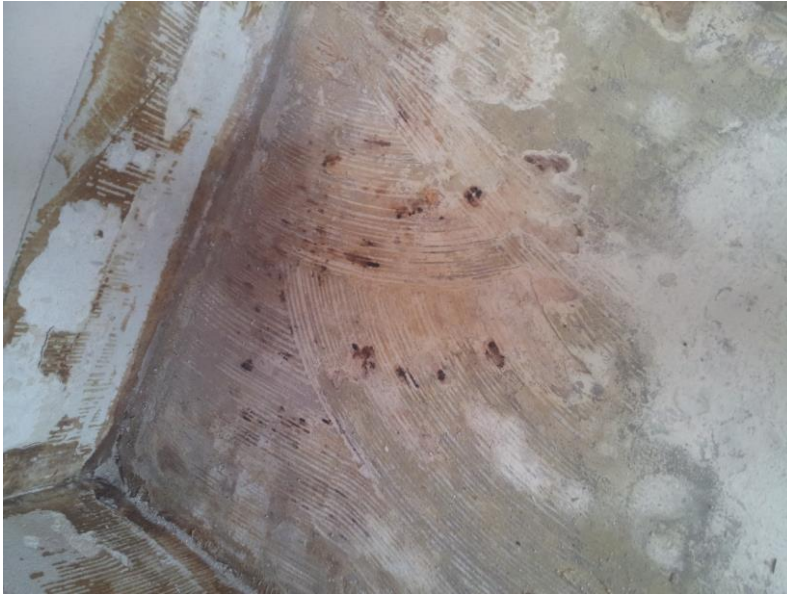
KUVA 3 Lattia mattojen purkamisen jälkeen
