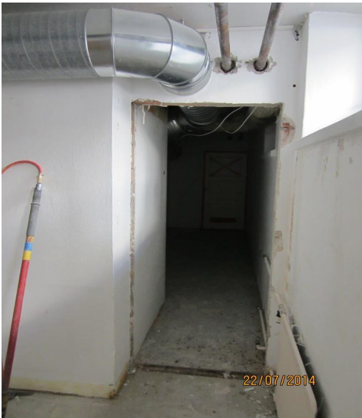
KUVA 6 Oven karmit ja asbestieristeet putkista purettu
