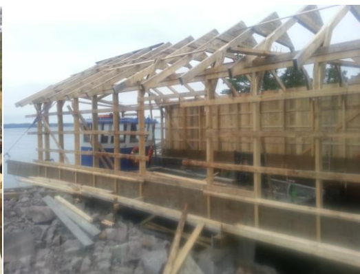
Bild 7 Konstruktion i lösvirke (Lindroos, 2015).
