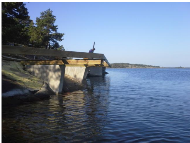
Bild 11. Bryggfundament gjutna på berg (Lindroos, 2015).
