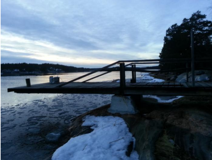
Bild 12. Bryggkonsol försedd med vajer i räcket (Lindroos, 2015).
