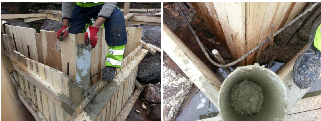
Bild 22. Undervattensbetong (Lindroos, 2015).
