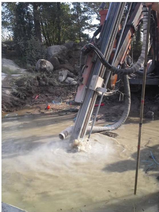
Bild 16. Bergborrning under vatten (Lindroos, 2015).
