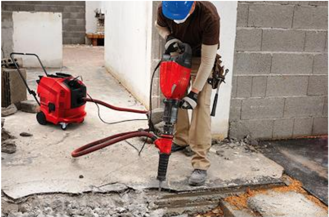
Kuva 5. Korkeapaineinen kohdepoisto piikkauskoneessa. [6.]
