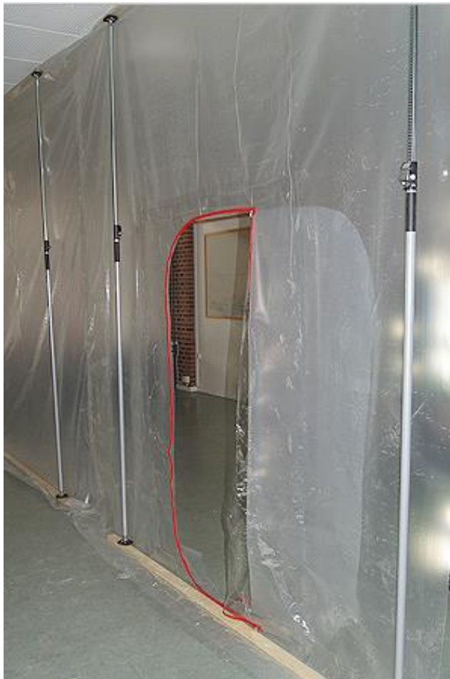
Kuva 7. Kevyt suojaseinä. Läpikulku toteutettu vetoketjuovella. [8.]
