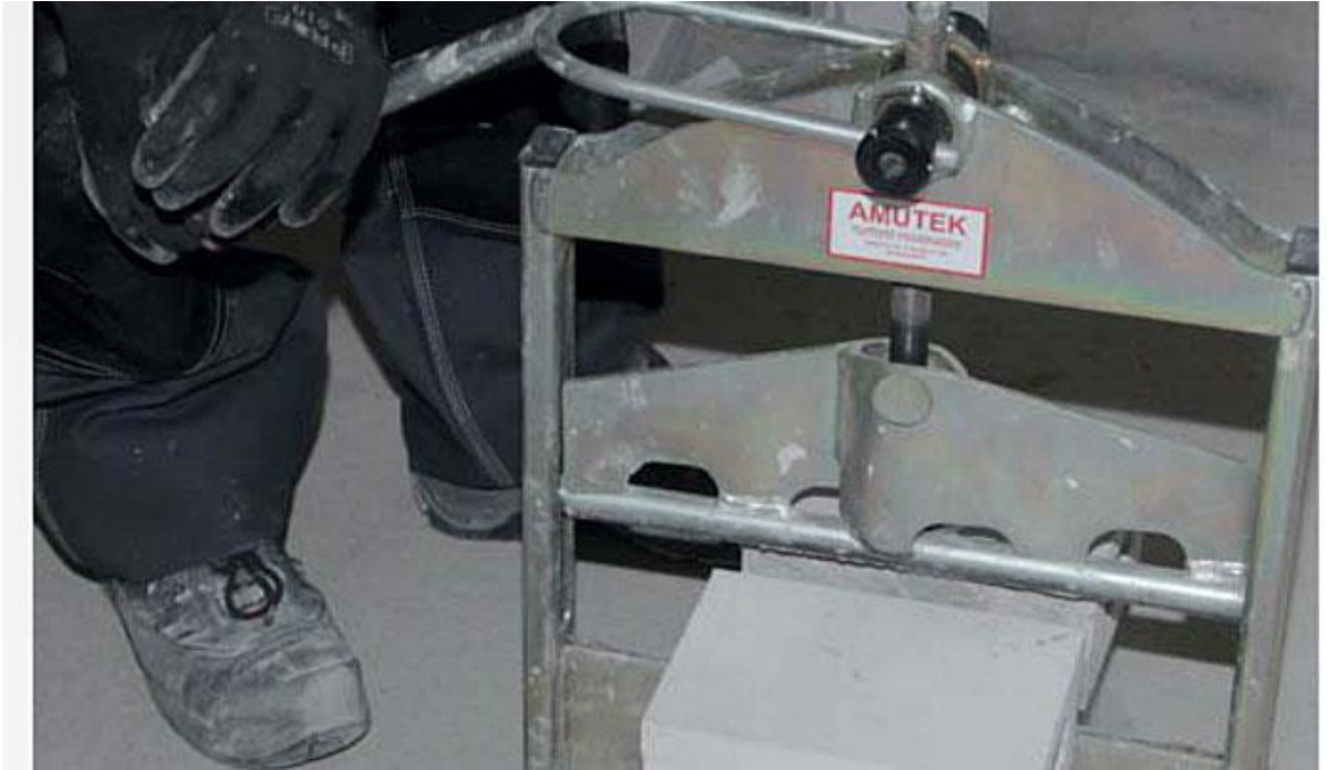
Kuva 4. Harkon katkaisu tiilileikkurilla.[5.]
