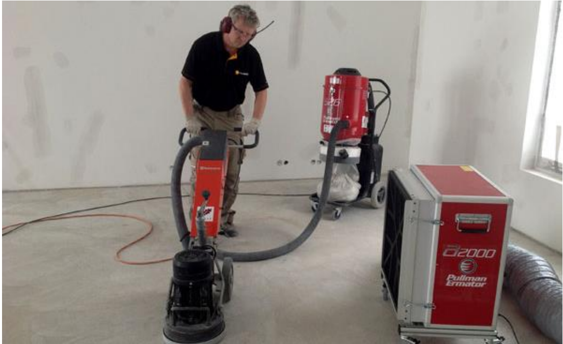
Kuva 6. Korkea- ja matalapaineinen kohdepoisto lattiahiontatyössä. [9.]
