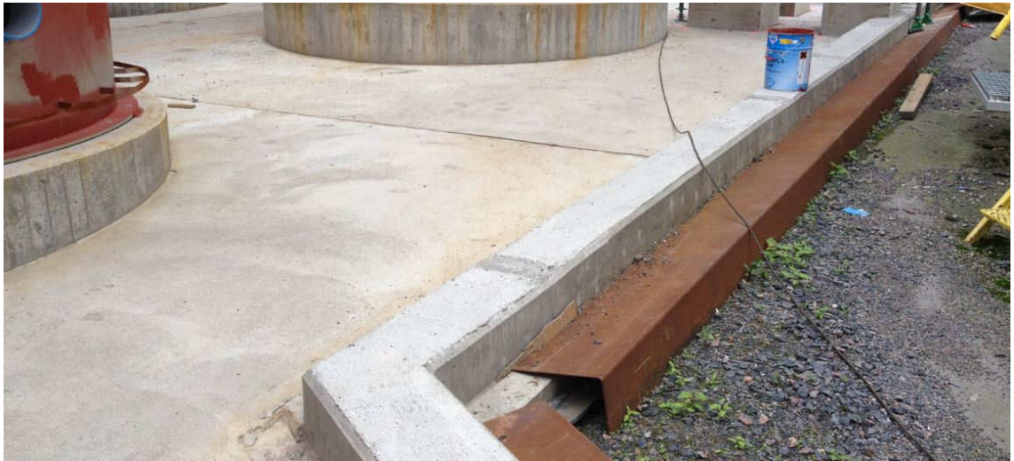
Kuva 29. Uusi betonivallirakenne olevaan säiliötilaan.
