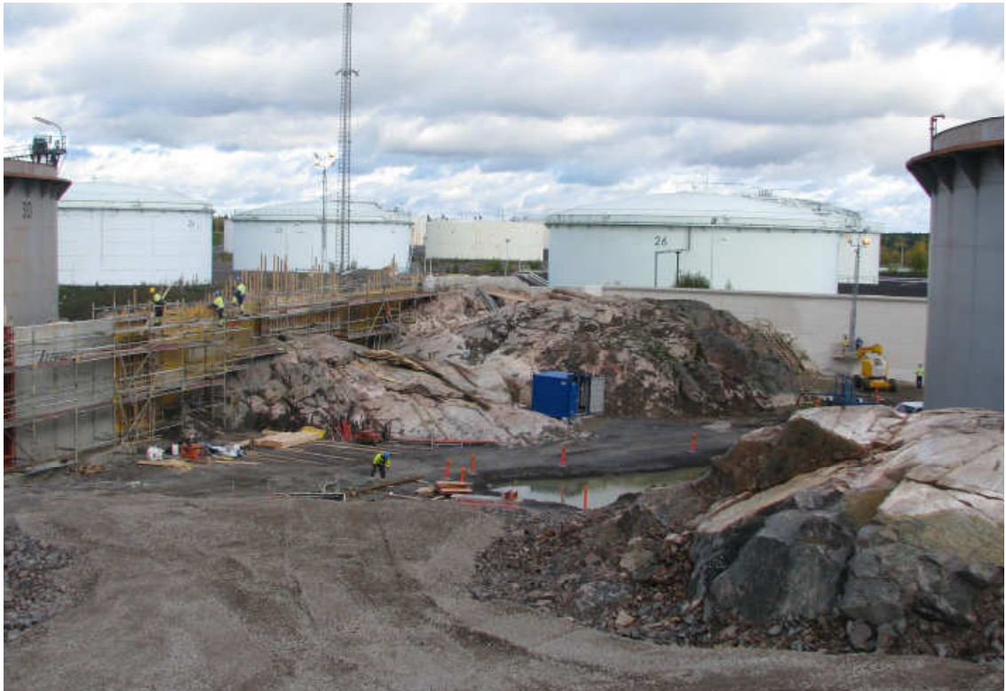
Kuva 28. Vallitilan kunnostamisen aiheuttamia maanrakennustöitä. (Neste 2013, 2)
