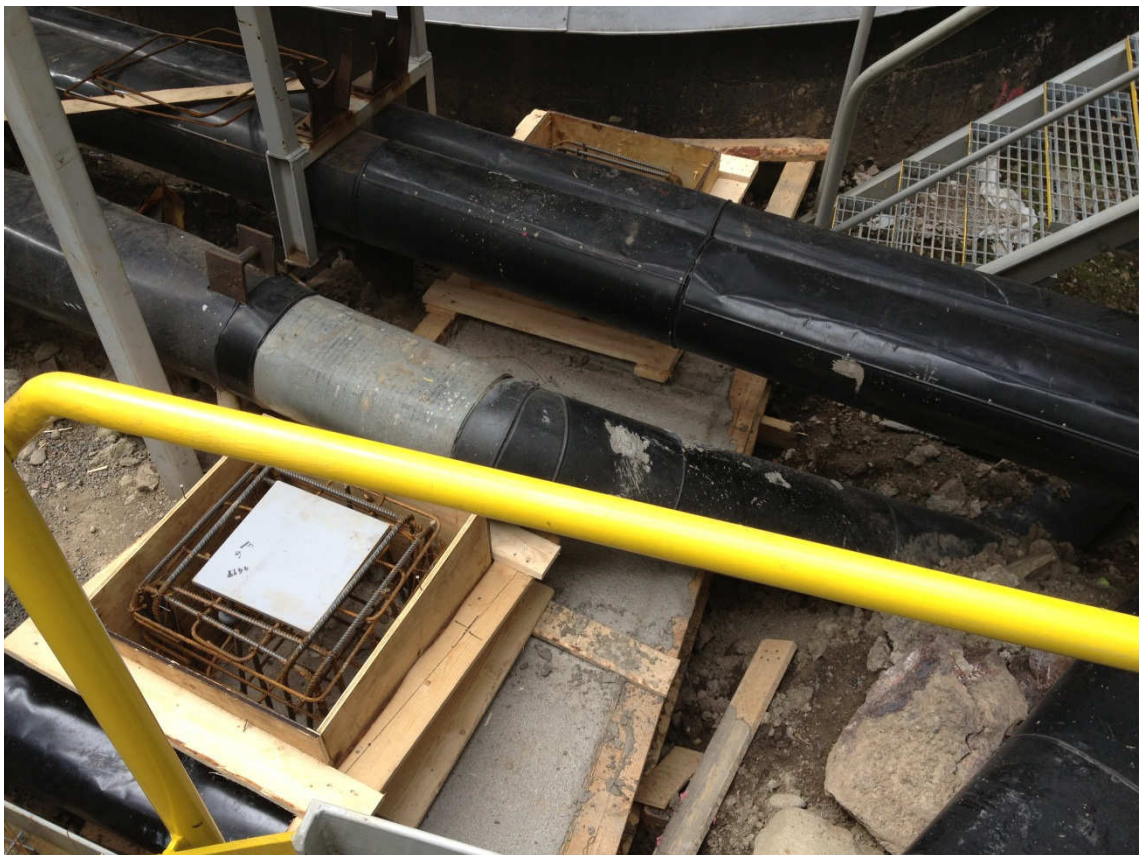
Kuva 32. Haastavat työolosuhteet olevien rakenteiden keskellä.
