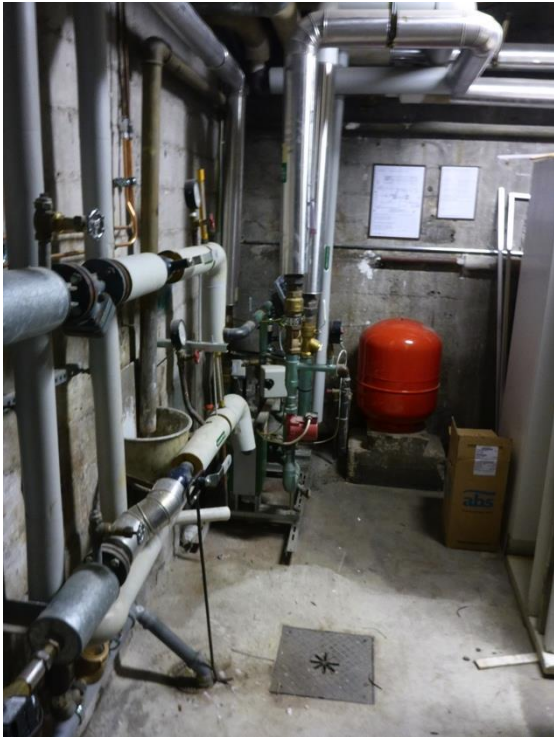
KUVA 10. Näkymä teknisestä tilasta
