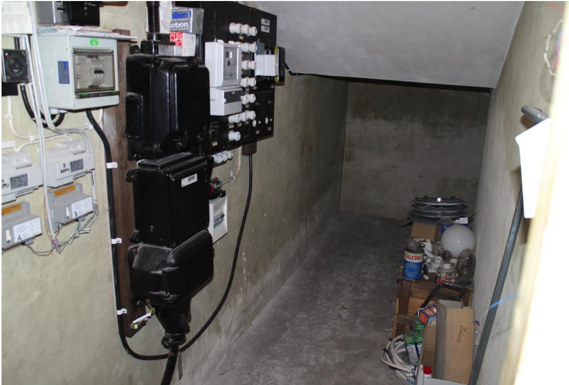
KUVA 16. Alkuperäinen sähköpääkeskus
