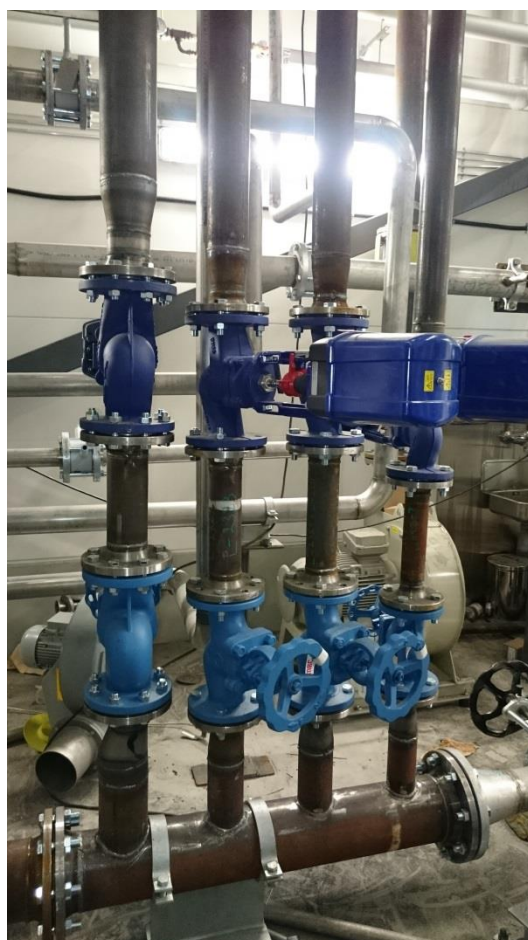
KUVA 28. Ilmanjakotukin venttiiliryhmä.
