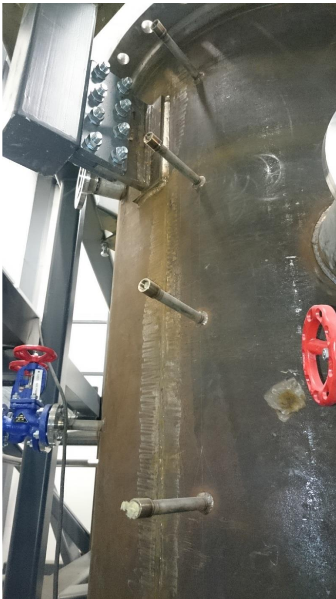
KUVA 20. DN 15 mittausyhteet.
