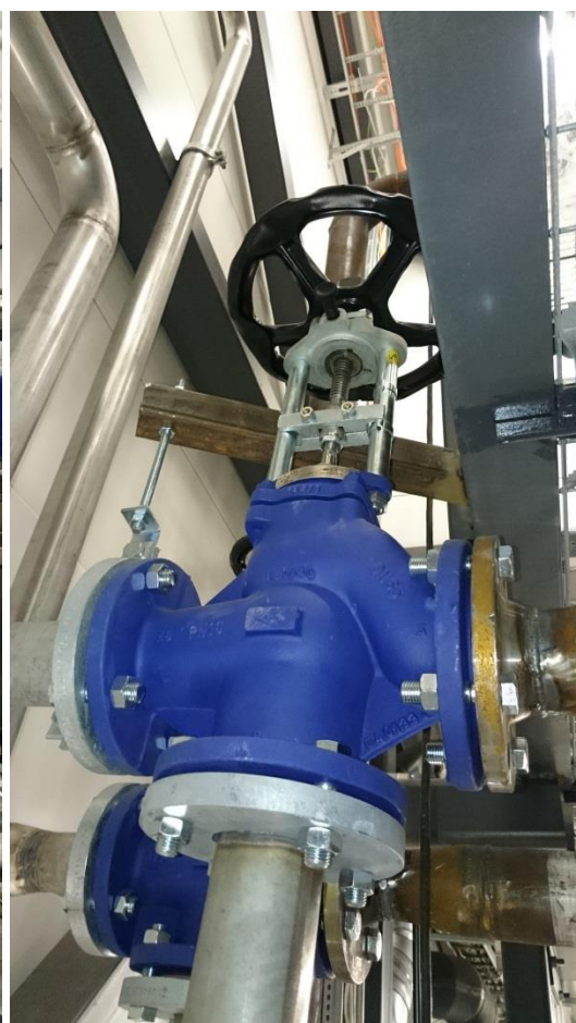
KUVA 29. Käsikäyttöinen kolmitieventtiili.
