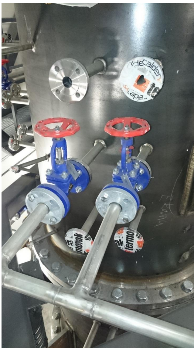
KUVA 16. Sekundääri-ilmansyöttöyhteet.
