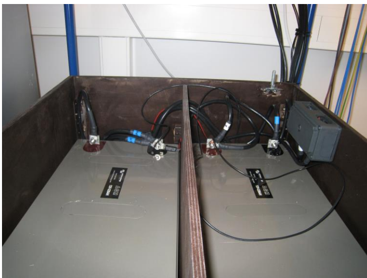
KUVA 4. Victron Energy AGM 12-220-akusto
