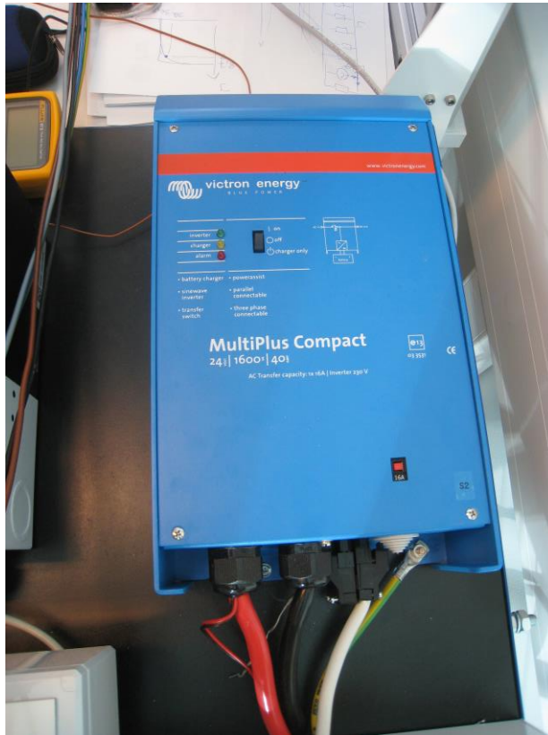
KUVA 5. Victron Energy MultiPlus Compact C 24/1600/40 –invertteri/laturi
