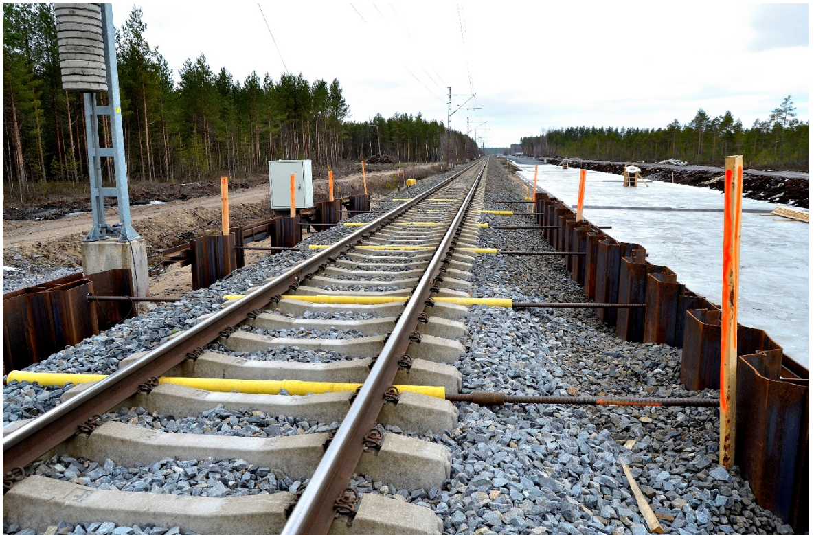
Kuva 2. Työnaikainen tukiseinä ankkuroituna vetotangoihin ratapenkereen vastapuolelle asennettuihin ponttiprofiileihin.
