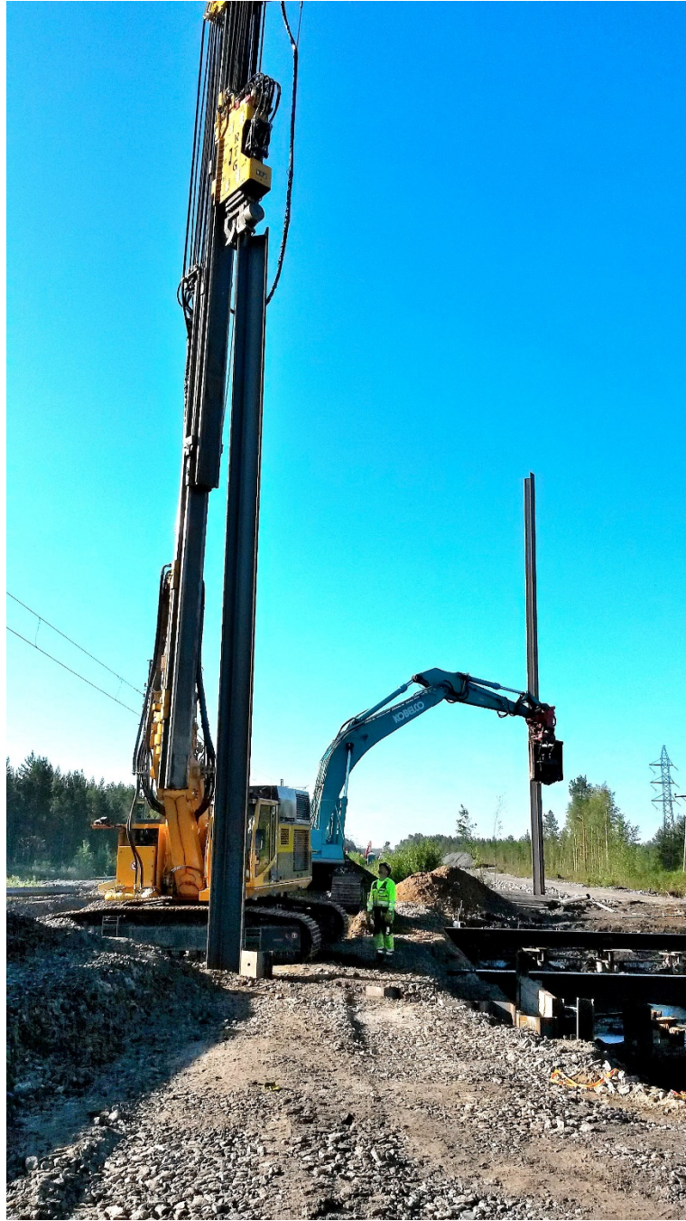
Kuva 3. Pysyvän teräsponsin asennusta liikennekatkossa pontiniskijällä.
