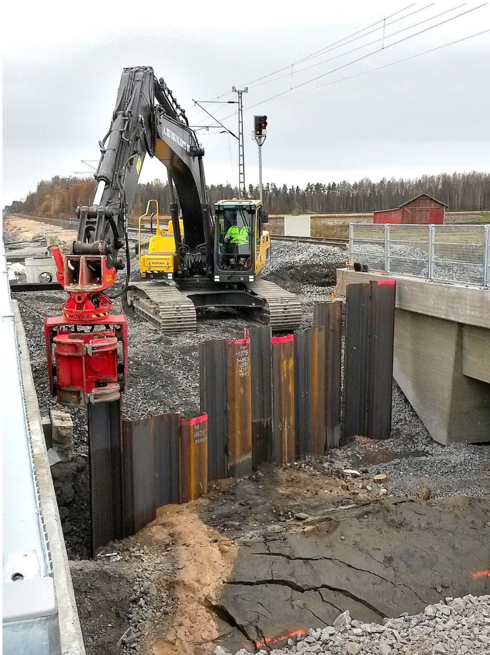
Kuva 4. Pysyvän teräsponttiseinän asennus ponttivasaralla liikennekatkossa.
