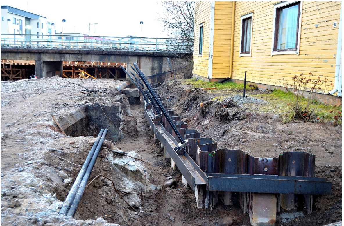
Kuva 1. Kallioankkurein tuettu tukiseinä.
