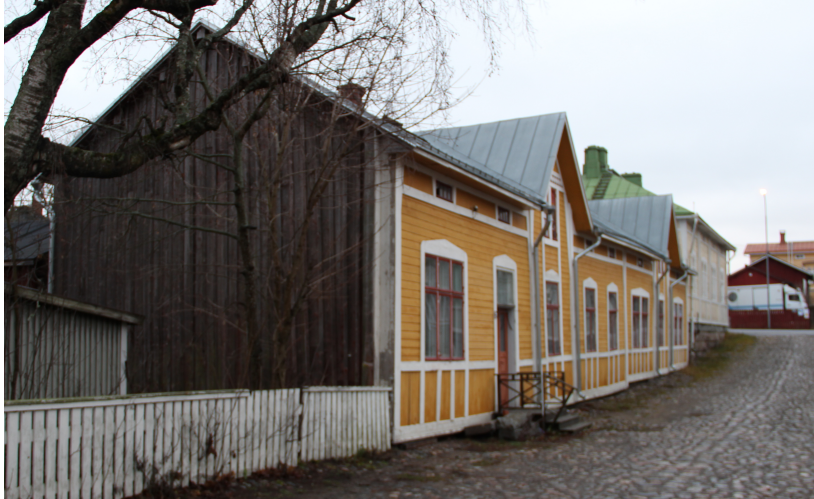
Kuva 7. Kohteen pääjulkisivu ja päätyseinä ovat täysin erilaisia. Eron hahmottaa paremmin, kun nämä kaksi seinää kuvataan yhteen kuvaan. Kristiinankaupunki 2014.
